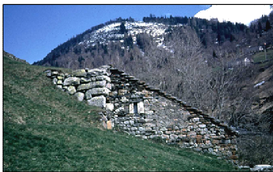
Ouvrage en maçonnerie traditionnelle (Barèges)
