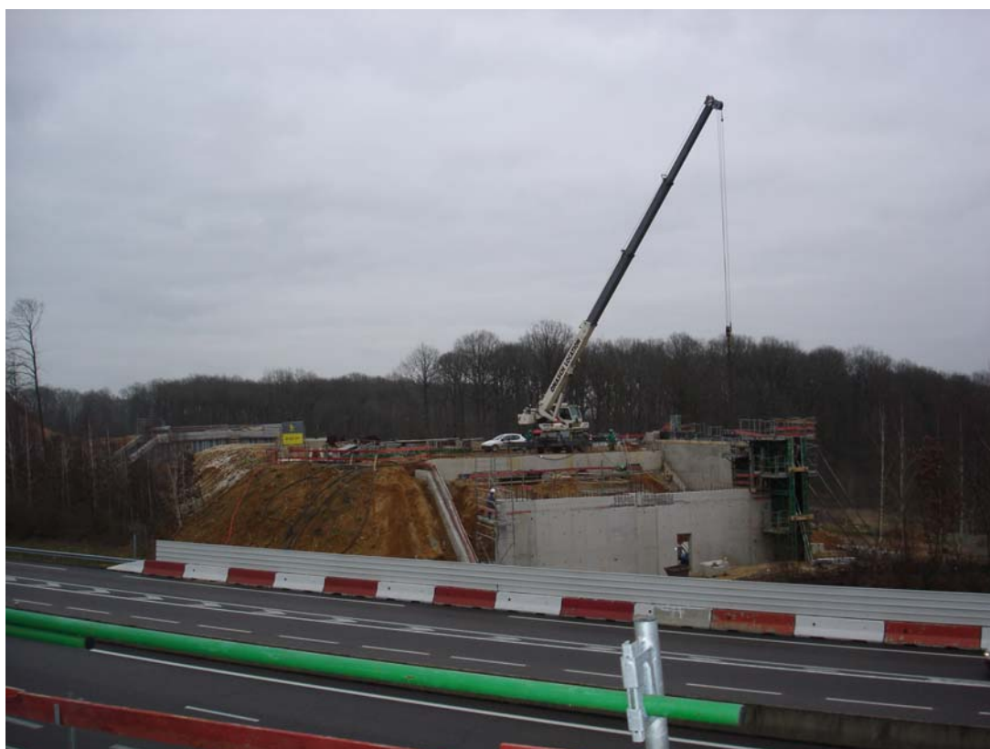
Quelques vues du chantier
