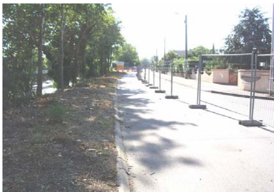
Dépose des glissières de sécurité et pose clôtures de chantier
