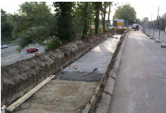
Terrassement et béton de propreté
