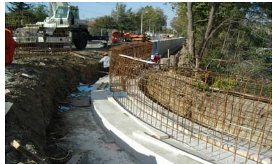
Ferrailage des fondations
