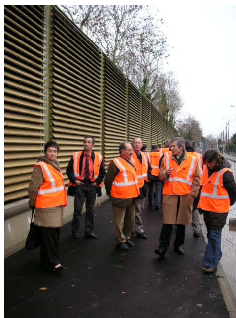
Pendant la visite du chantier
