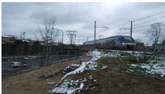
Proximité de la voie ferrée et de la rocade
