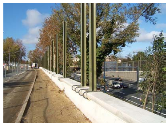
Pose des poteaux
