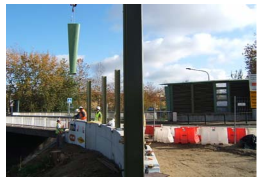
Pose de l'élément d'extrémité
