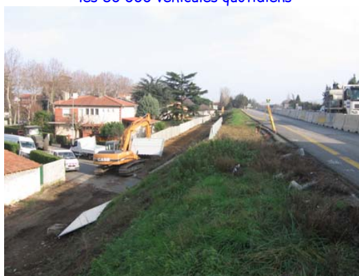
La proximité étonnante des travaux soit des riverains soit des voies communales en circulation
