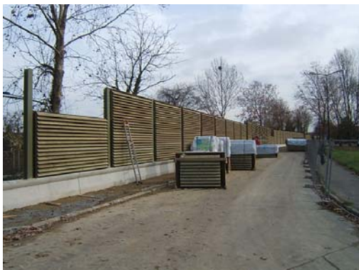
Chantier en cours de pose de panneaux
