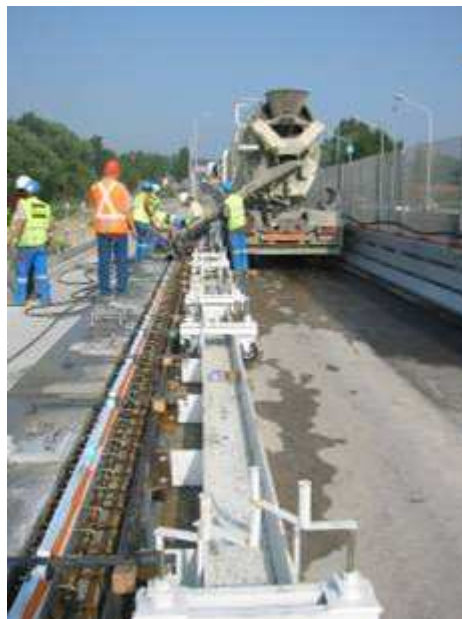
Pose des écrans anti-bruit
