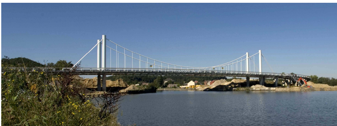
Photo du Pont de Kanne en Belgique (Freyssinet International)
