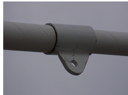
Pont de Kanne - détail câble porteur
