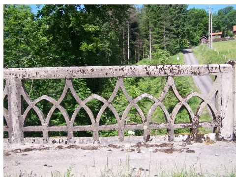
Pont rail de Férrières sur Sichon
