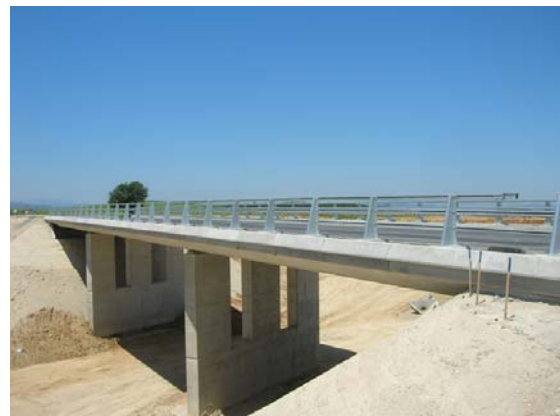
Les ponts à poutres préfabriquées
