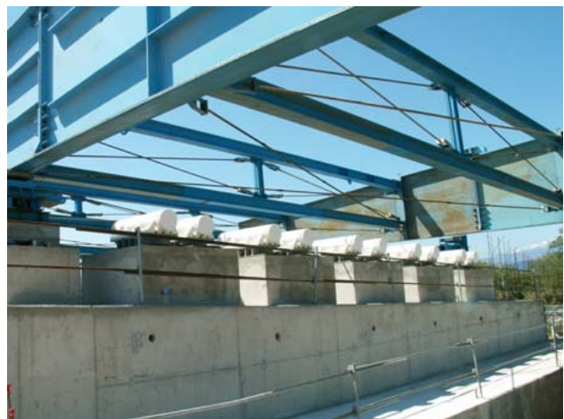
Le déroulement des travaux (Appuis)
