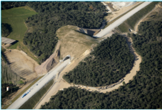
Les principaux viaducs en Espagne
