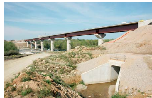
Viaduc sur le Tech
