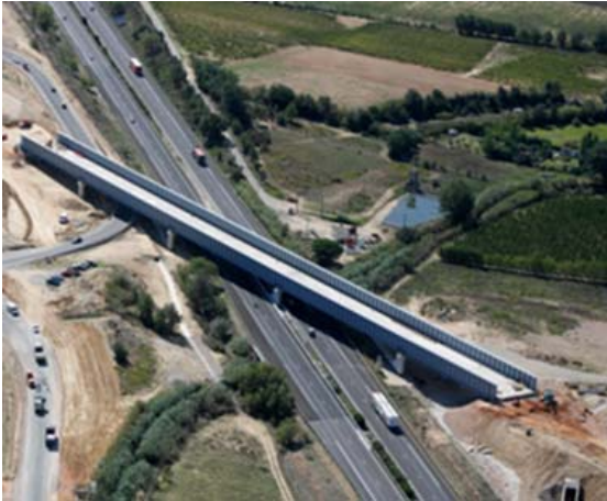
Viaduc sur A9
