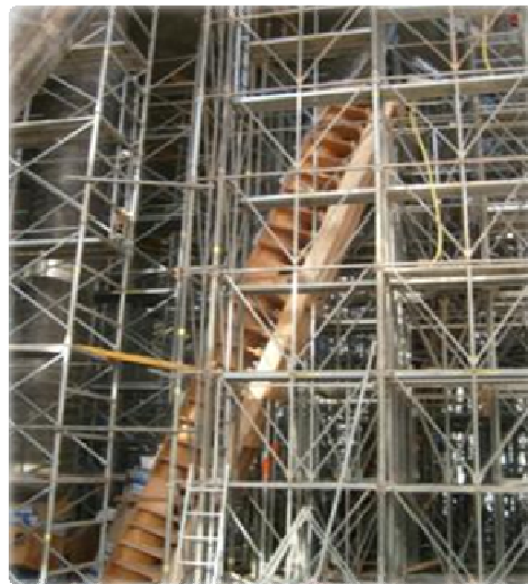
Coffrage en bois supportant les poteaux inclinés
