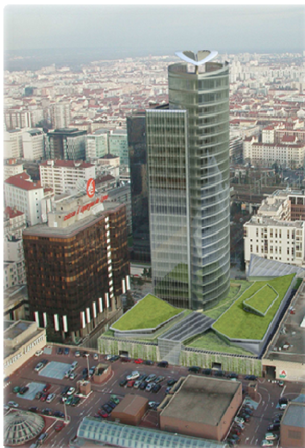
La tour Oxygène en élévation
