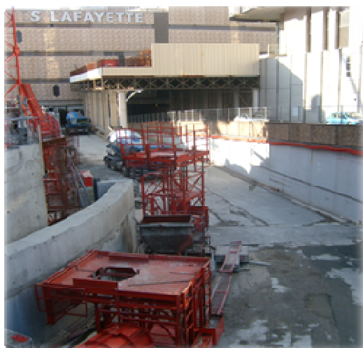
Plateforme d'assemblage du ferrailage
