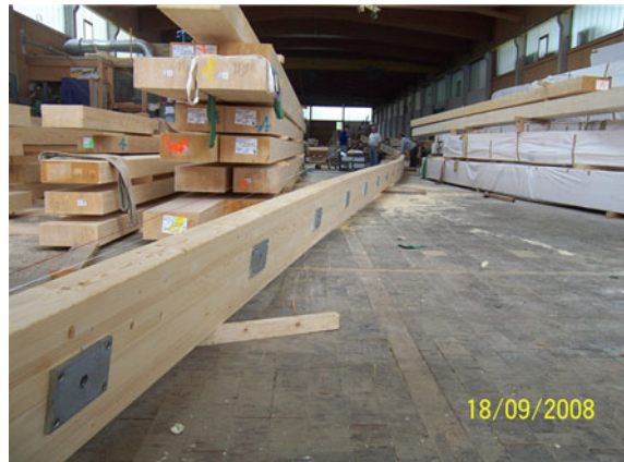
Assemblage à sec en usine pour contrôle sur 50 m
