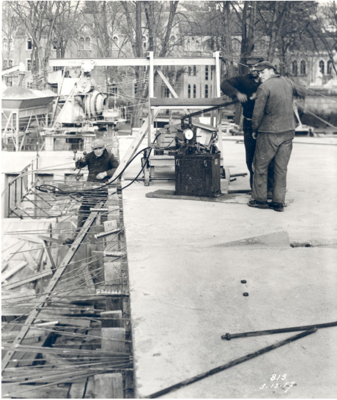
Mise en tension des câbles
