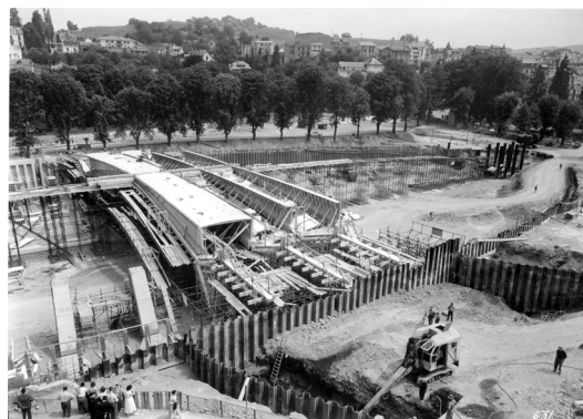
Coffrage et ferrailage
