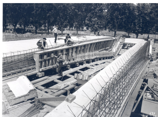
Coffrage du flanc d'un arc
