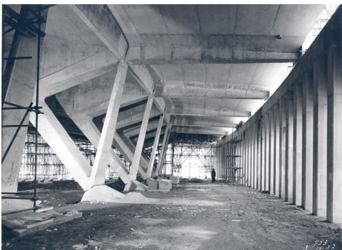
Contreforts du mur d'enceinte
