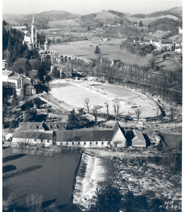
Vue générale le 5-02-1958
