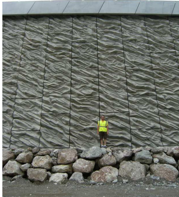
Les murs de la Dranse : une échelle gigantesque
