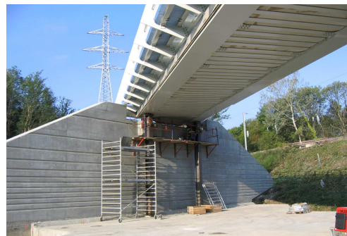
Pont prêt à être poussé (Source : Campenon-Bernard)
