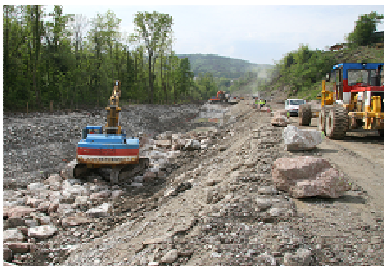
Enrochements en pied de mur (Source : DTP terrassement)
