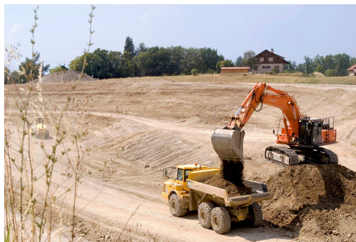
Terrassements en grande masse (Source : DTP Terrassement)
