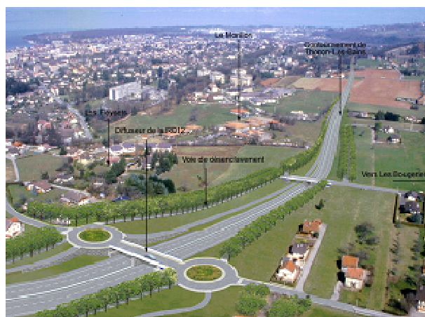
Séquence au niveau de la RD12 en regardant vers Evian
