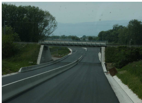
Pont posé et mis en service
