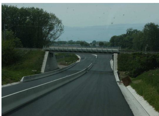
Le pont rail du Bois d'Anthy
