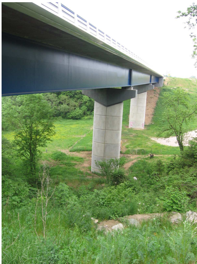
Viaduc du Pamphiot, vue générale
