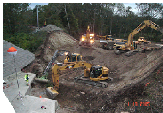
Au matin, les pelles ont bientôt terminé. (Source : Campenon-Bernard)
