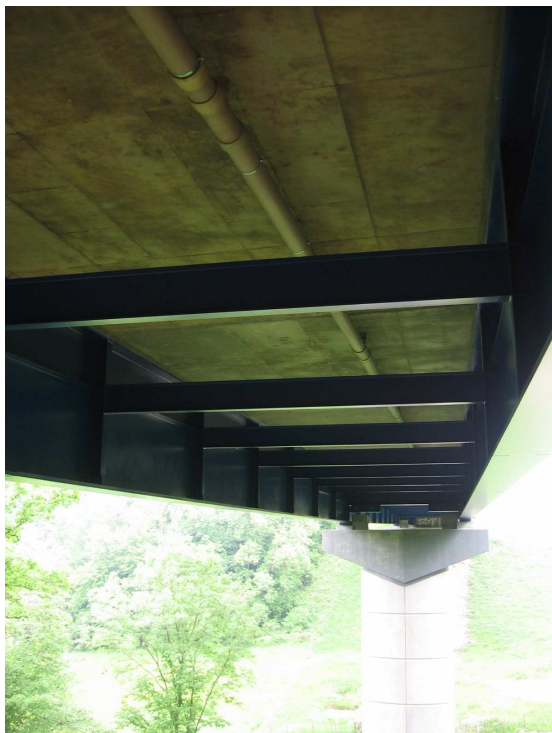
Viaduc du Pamphiot, vue de dessous
