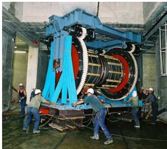
Ripage du treuil sur coussin d'air
