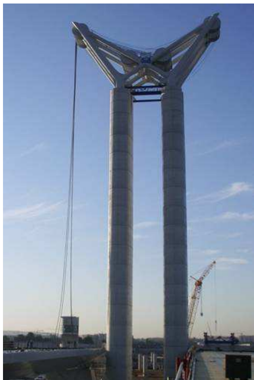
Levage et mise en place des câbles
