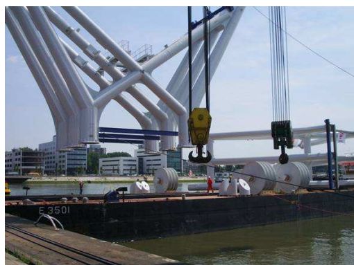
Mise en place des blocs poulies sur les papillons
