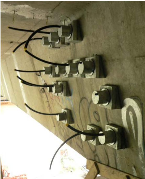
Vue extérieure et intérieure sur culée après mise en tension
