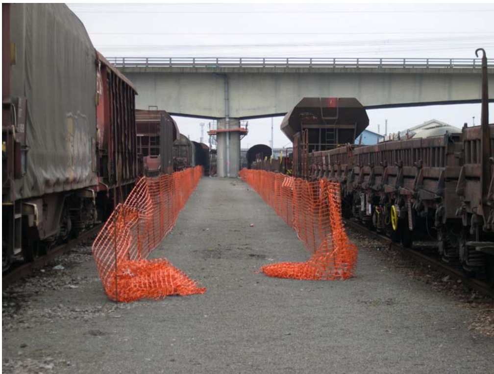
CHEMINEMENT ET ACCES A LA PILE P3 (DANS LE TRIAGE)
