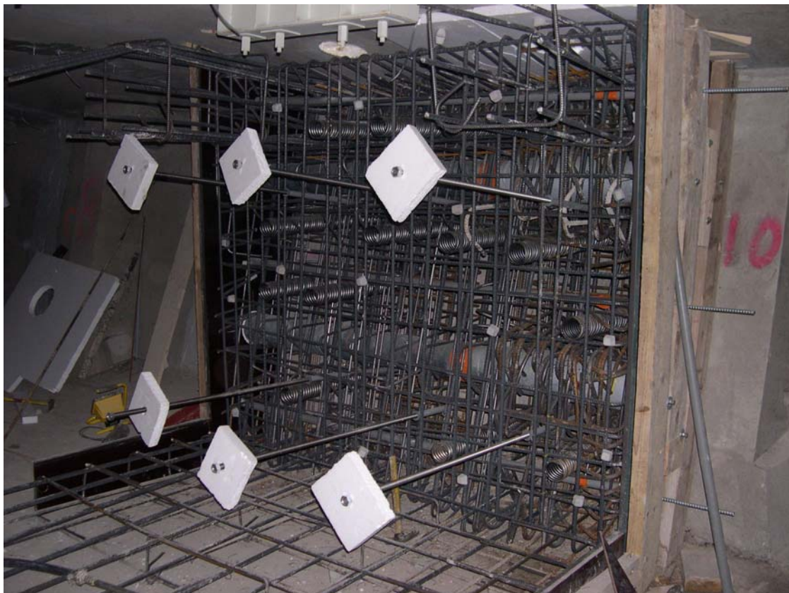
FERRAILAGE ET GAINES DE PRECONTRAINTE DANS UN MASSIF D'ANCRAGE
