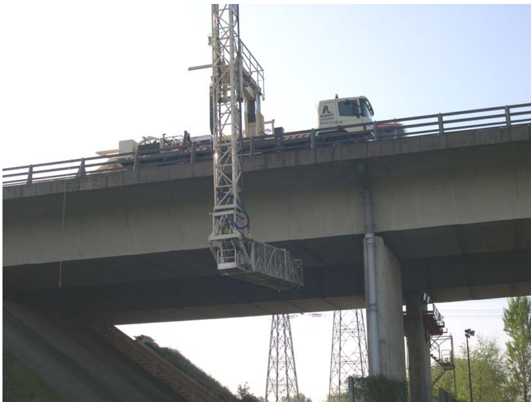
TRAVAIL DEPUIS NACELLE DEPORTEE EN SOUS FACE DE CAISSON
