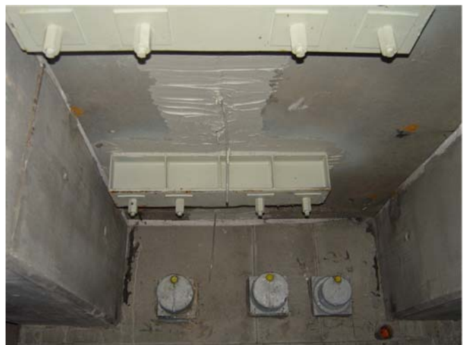
Ancien et nouveau renforcement
