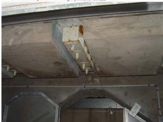
Traitement 1989 joint VSC/V1
