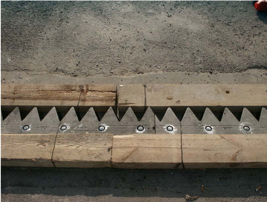
TRAITEMENT DU JOINT DE CHAUSSEE EN PHASE PROVISOIRE
