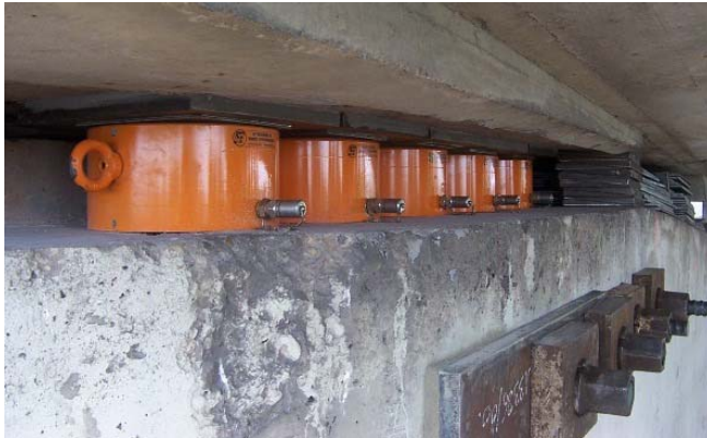
Zone de vérinage piles principales
