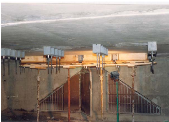
17/10/89 - Sens Metz - Paris Côté Metz Poutre métallique et coffrage poutres béton
