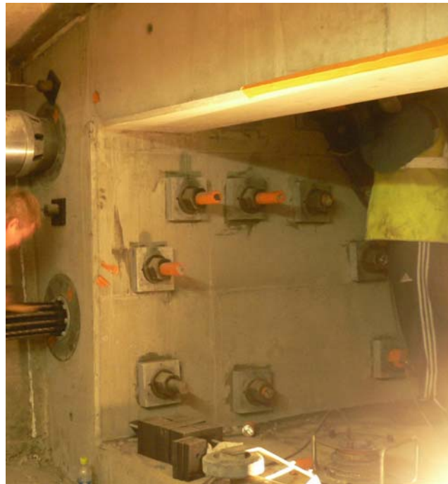
Vue extérieure et intérieure sur culée après mise en tension
