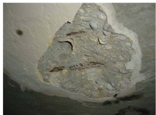
Vue intérieure du caisson
