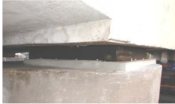
Bossage pile principale
