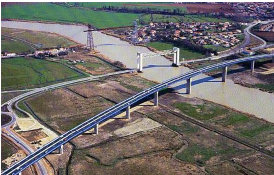
Pont du Martrou sur la Charente (travée : 92.6 m)
