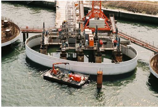
Les extérieurs des socles : de novembre 2004 à mai 2005
