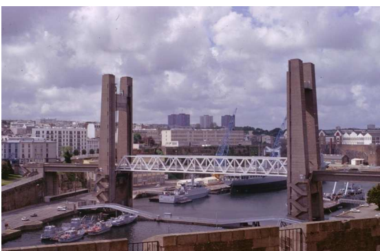
Pont de Recouvrance (travée : 87.5 m)
