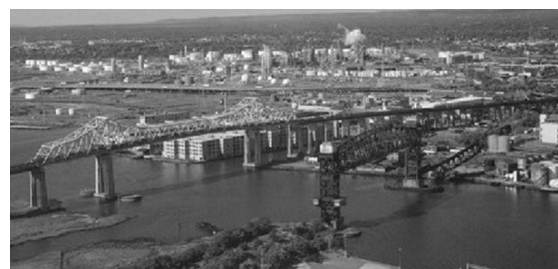
Arthur Kill Bridge - New-Jersey (travée de 170 m)
