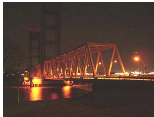
Kattwyckbrücke à Hambourg (travée : 106 m)
