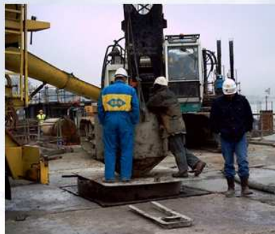
Bétonnage pieux 1800
