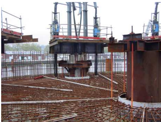
Gabions: 2 vérins sur 1 tube diam. 1412
