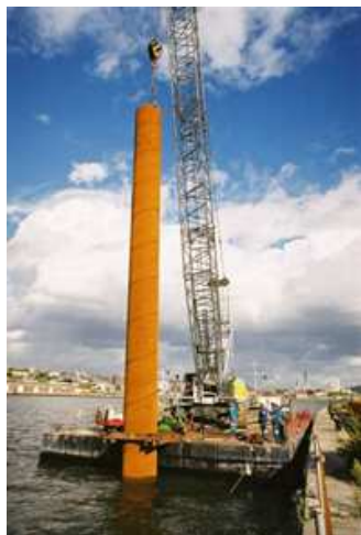
2. Pose sur les tubes des 13 éléments préfabriqués à terre
