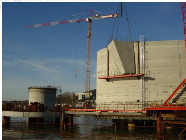
Pose coque préfabriquée avant descente du socle
