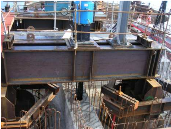
Socles: 1 vérin sur 2 tubes diam. 1800
