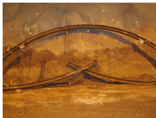
Figure 9 : Cintre de soutènement
