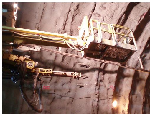
Figure 13 : Equipements d'attaques du front
