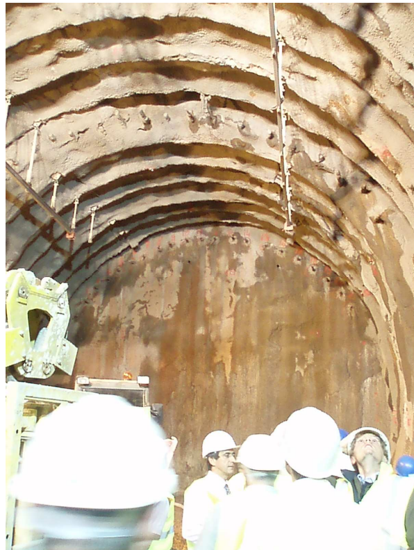
Figure 14 : Front de taille de l'attaque Est. On peut observer les rails servant à la machine utilisé pour l'attaque du front
