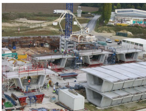
Zone de préfabrication des voussoirs.
