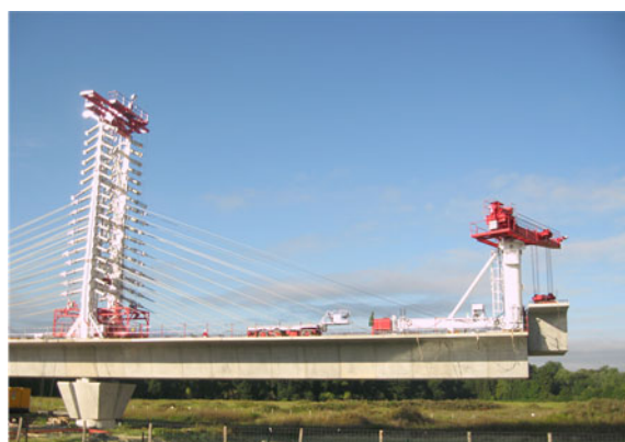
Mât de haubanage provisoire pour l'assemblage des voussoirs avant la pose de la précontrainte dans la travée.
