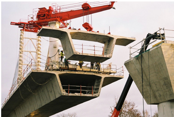
Pose d'un voussoir
