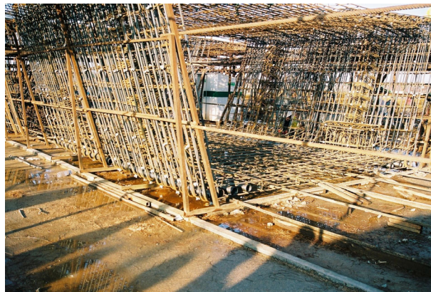
Ferrailage des voussoirs avant le coulage du béton
