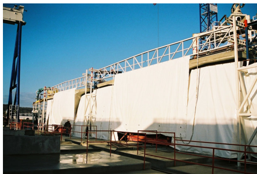
Les bâches enveloppantes pour assurer la prise du béton.
