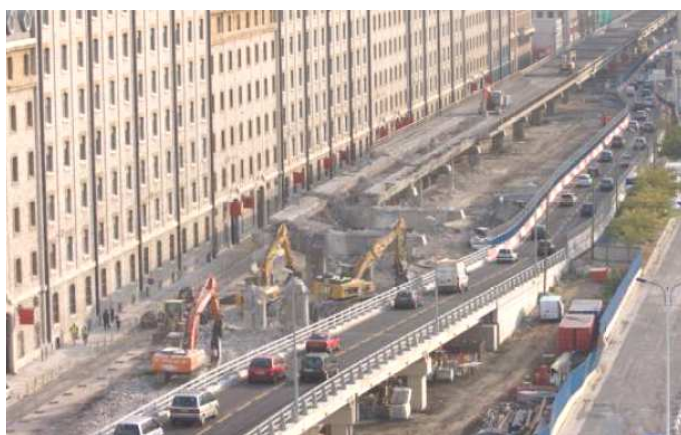
Vue sur la passerelle de descente provisoire (à droite) et sur la démolition de l'ancienne passerelle (à gauche)
