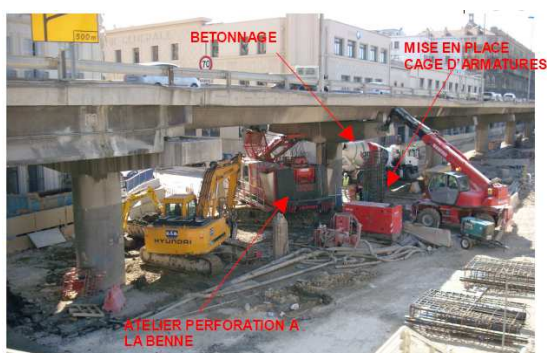
Réalisation des parois moulées au droit de l'ancienne passerelle
