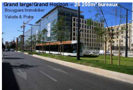
Tramway 2 sur le Boulevard de Dunkerque
