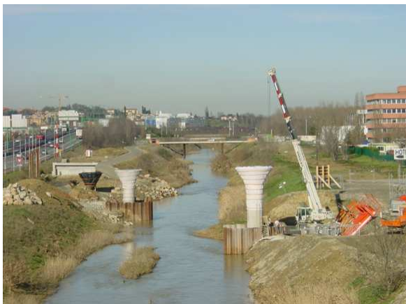
Construction des piles de l'OA-DE
