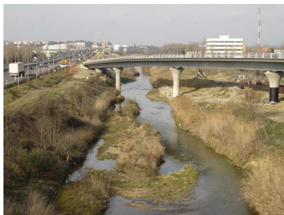
L'OA-DE à la fin des travaux
