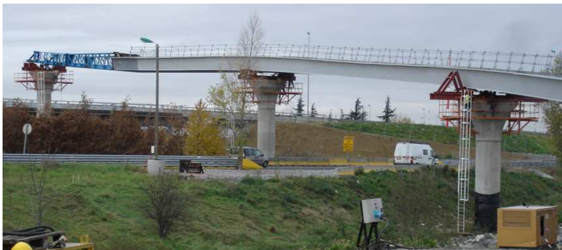
Phase d'accostage sur la pile P4
