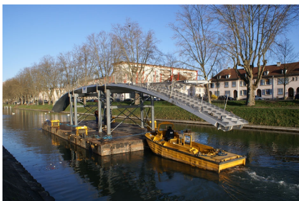
Transport du « colis » à l'aide d'un ponton remorqué
