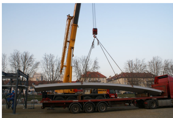
Livraison d'un tronçon d'arc
