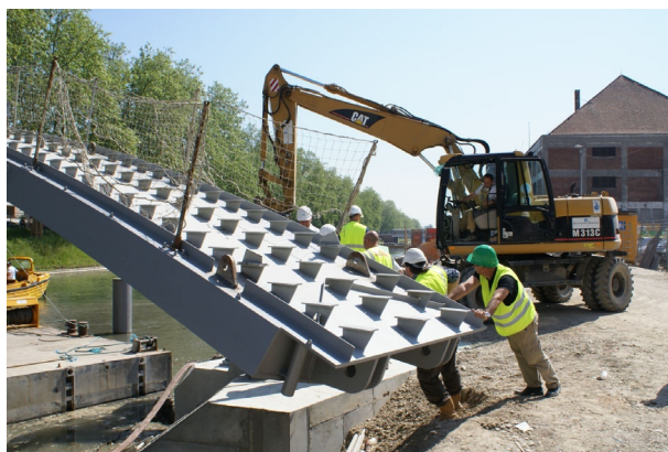
Positionnement sur les culées
