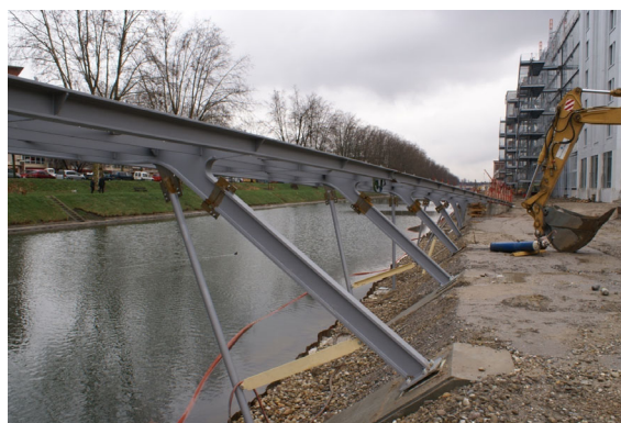
Rampes posées prêtes pour la soudure définitive
