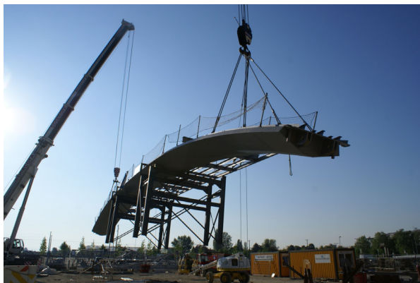
Une fois l'arc assemblé sur son châssis de montage avec la rampe-arc fixée latéralement, l'ensemble est solidarisé provisoirement avec le châssis.
