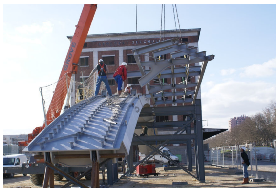
Mise en place de la rampe arc
