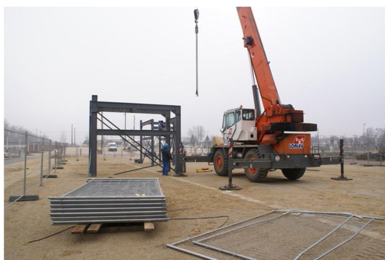
Aire d'assemblage aménagée sur la presqu'île pour assembler les trois éléments d'arcs, et à y adjoindre la partie de rampe latérale en encorbellement.
