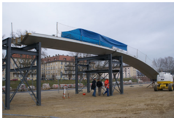
Assemblage des tronçons d'arc
