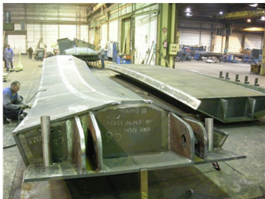
Les arcs ont été fabriqués en trois éléments
