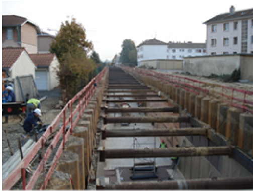
Photo de la trémie en cours de construction.
