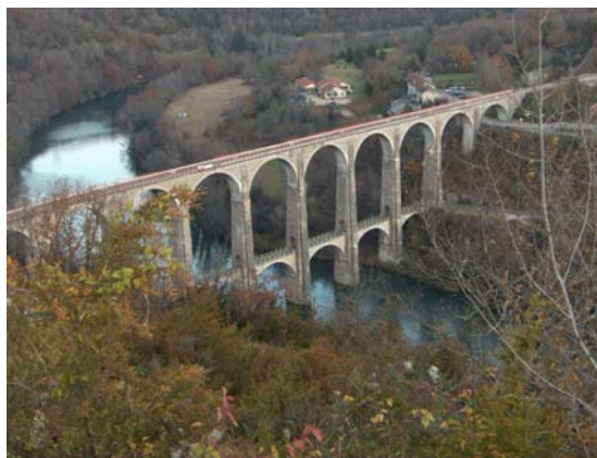
Viaduc de l'Ain
