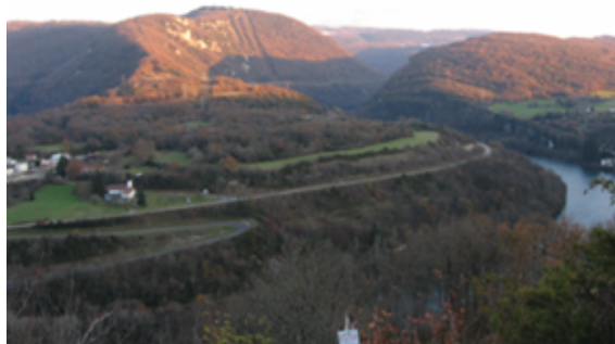
Le tracé vue du site du viaduc de l'Ain
