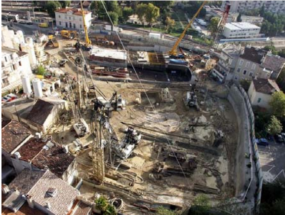
- Mai à Novembre 2005 : Travaux de parois moulées
