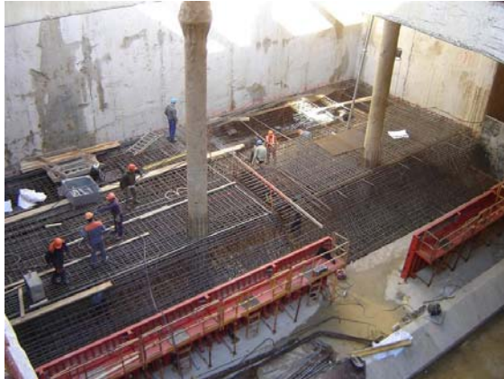
Réalisation du tunnel
