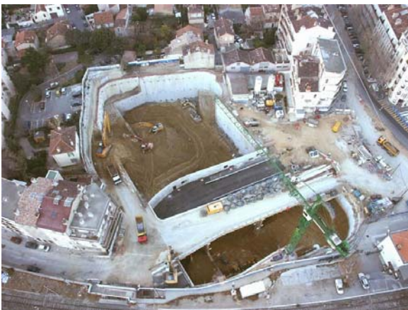
- Avril 2006 : Fin des terrassements
