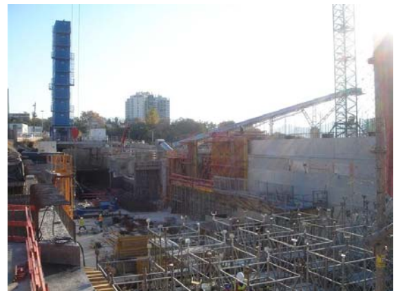
Conteneurs de stockage du tapis et évacuation des terres à la station La Fourragère
