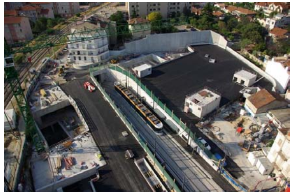
- Novembre 2007 : Passage du tunnelier
