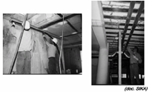
Figure 5 : collage de plats composites pultrudés.
