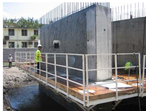
Pile P2 - Levée 1
