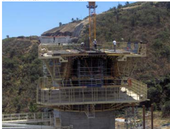
Voussoir sur pile 1
