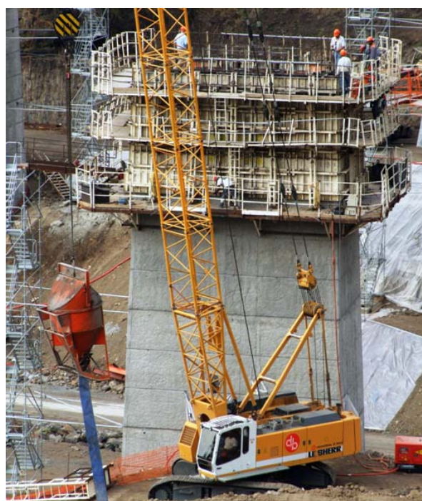
Outils-coffrant CTLM avec des levées de 4,500 m
