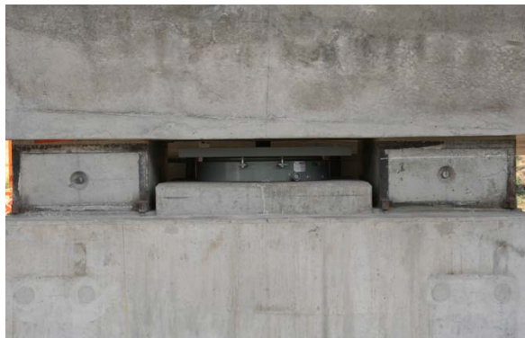
Appuis du tablier en phase de construction : cales provisoires en béton armé et appareils d'appui à pot injectables
