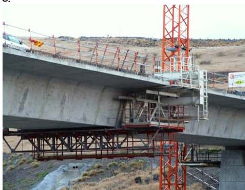
Réalisation du voussoir de clavage
