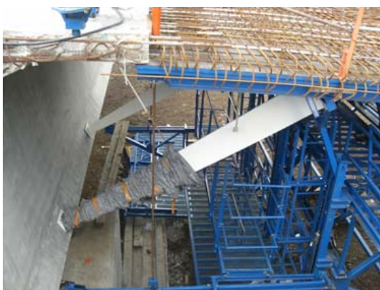
2ème phase : les encorbellements
