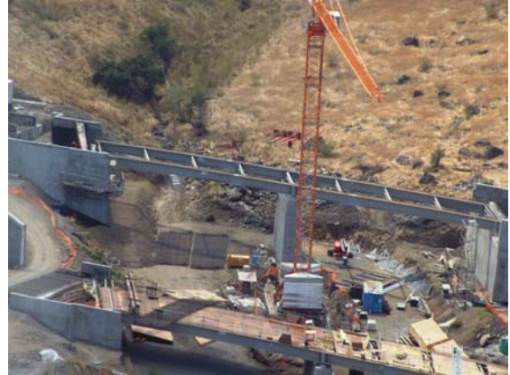
Réalisation du viaduc de Petit-Bras Canot (tablier mixte)
