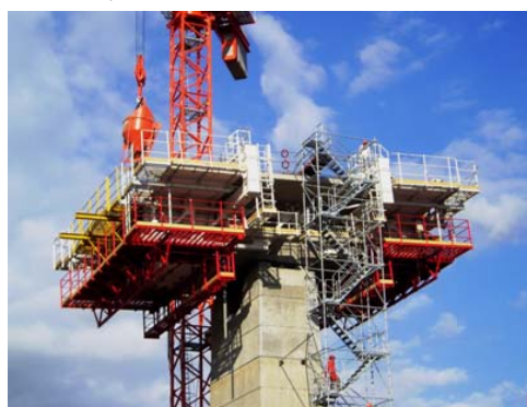
Bétonnage d'un voussoir courant
