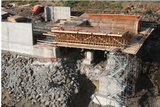
Réalisation des parties coulées sur cintre (cintre près de la culée CO du tablier Fleurimont côté Montagne)
