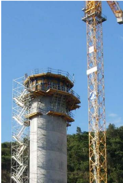
La pile P1
