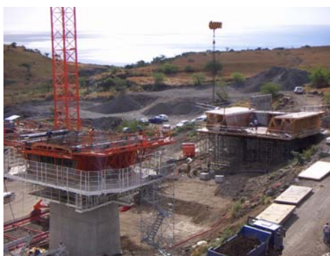
Réalisation d'un VSP et de la partie sur cintre du tablier
