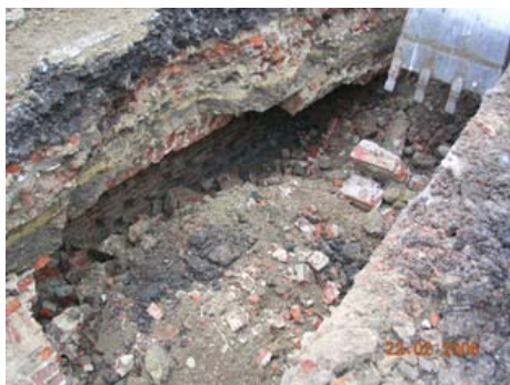
Purge du terrain
