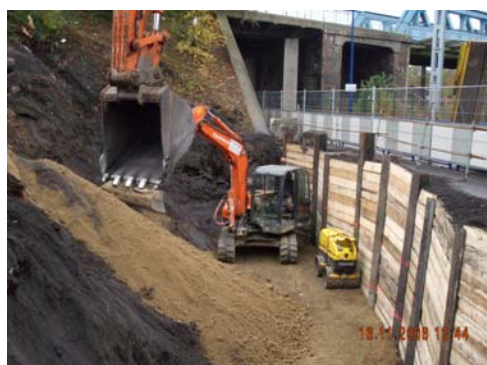
Blindage et purge du sol côté culée C2
