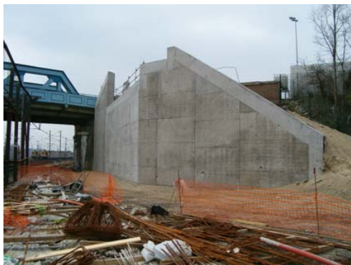
Culée C0 achevée
