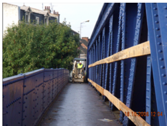
Décapage du trottoir
