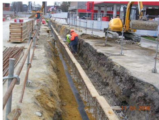
Terrassement et recépage des parois de pieux sécants
