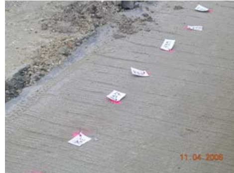
Murette d'implantation des pieux
