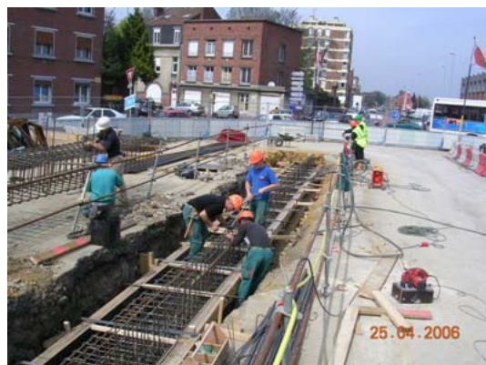
Poutres de couronnement et pose des préfabriqués
