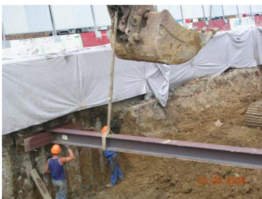
Terrassement de la trémie
