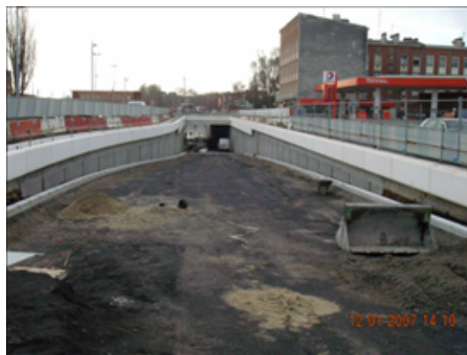
Aménagement des VRD
