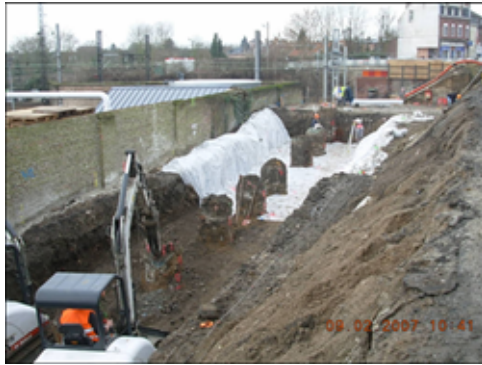
Réalisation des fondations profondes
