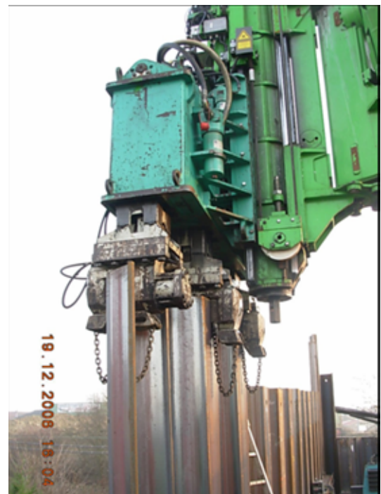
Exécution des rideaux de palplanches
