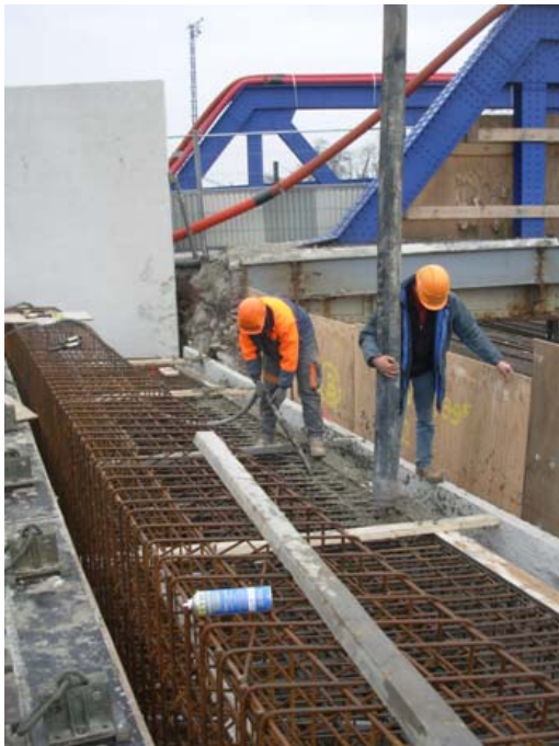
Réalisation des appuis
