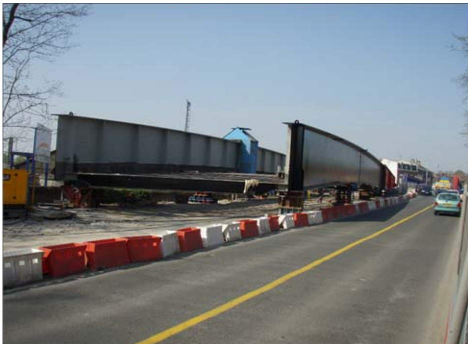
La charpente métallique du pont de Valenciennes
