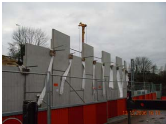
Montage du mur Terre Armée
