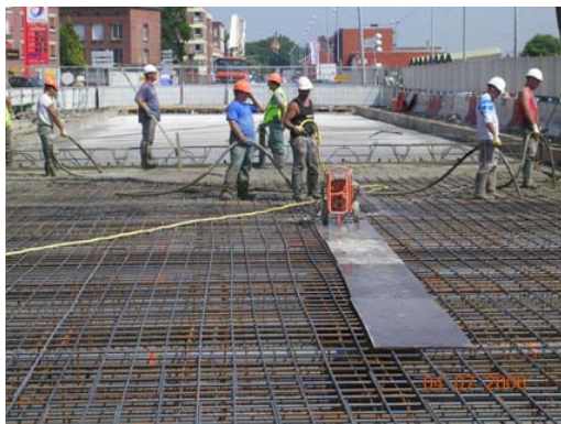
Bétonnage de la traverse supérieure
