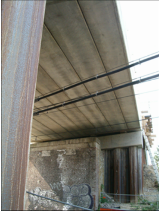
Tablier vu de dessous
