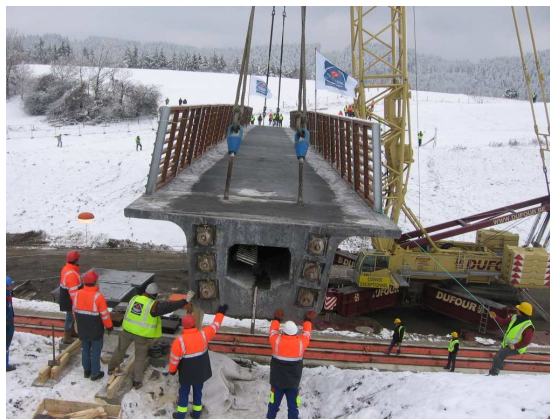
La mise sur appuis provisoires
