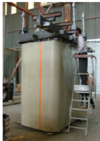
Le coffrage central monolithique avec bielles
