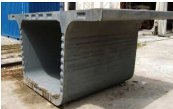
Un voussoir courant à l'usine de préfabrication de Romagnieu
