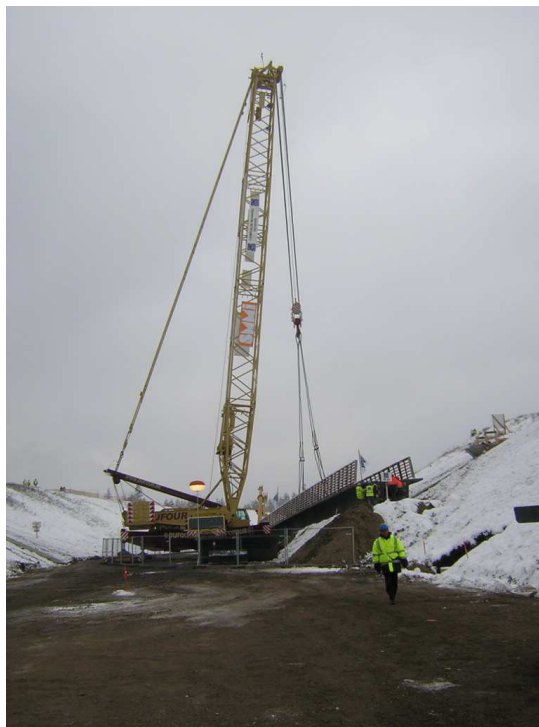
Le démarrage de l'opération, la grue en action
