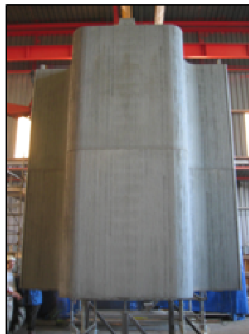
Deux voussoirs conjugués sur un poste de préfabrication
