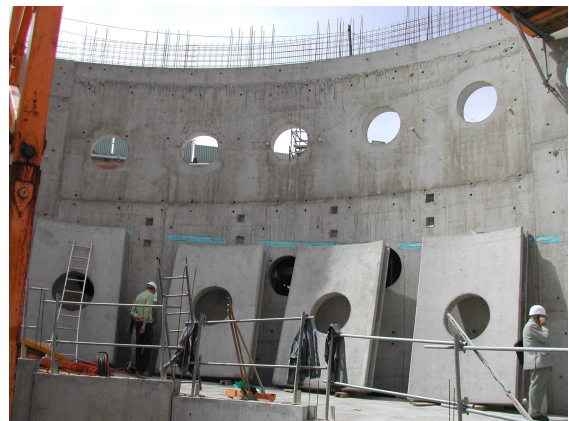
Stockage des éléments préfabriqués
