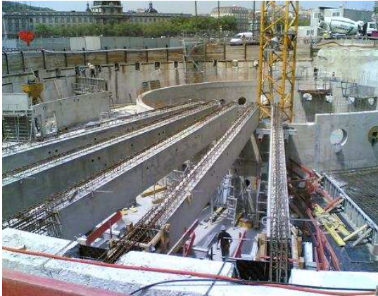
Poutres de la dalle de couverture
