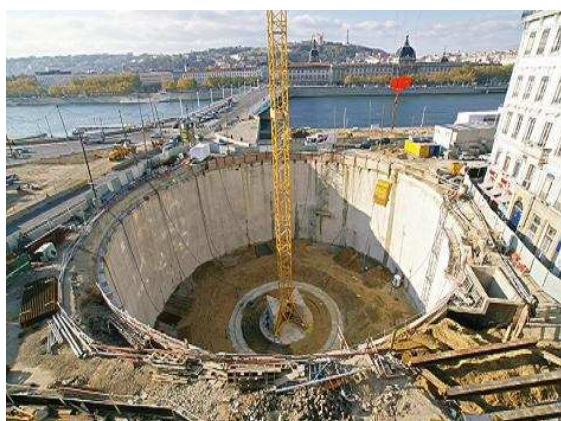
Chantier en phase terrassement
