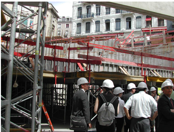
Visite du chantier de la Fosse aux Ours
