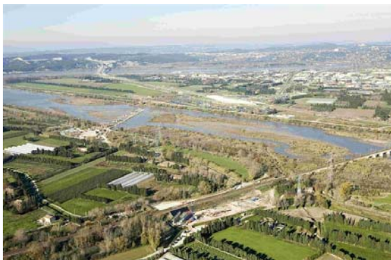
Photo aérienne du site d'implantation
