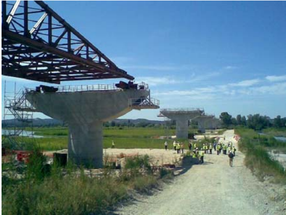
Chantier du viaduc sur la Durance
