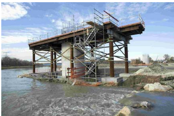
Élévation d'une pile dans la Durance
