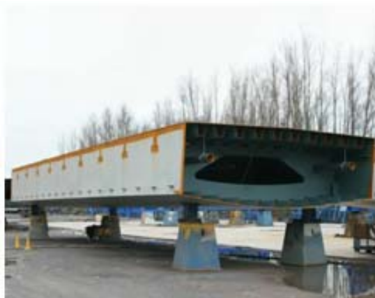
Chargement des tronçons TR1 et TR2 à BUMAR
