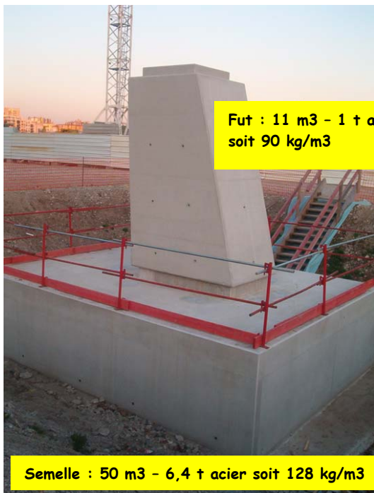
Pile P2 dans le futur parking
