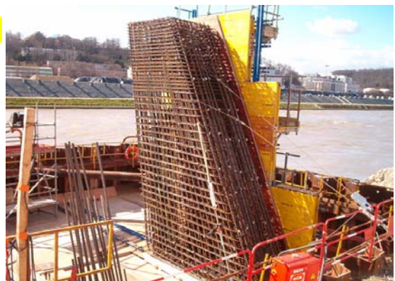
Ferrailage du fût de pile P1
