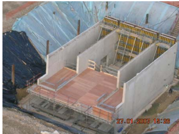
Culée C3 dans le futur parking
