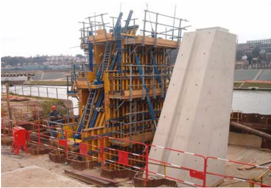
Coffrage d'un fût
