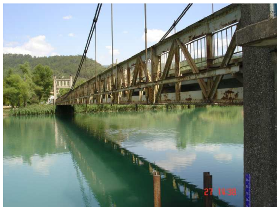
L'ancien pont suspendu
