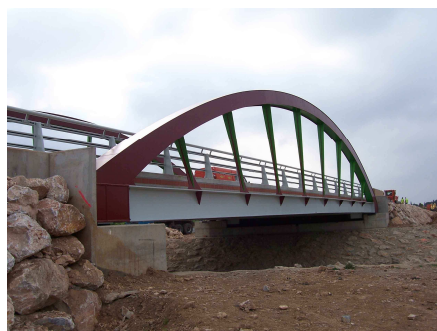
Le nouveau pont sur le Roboul
