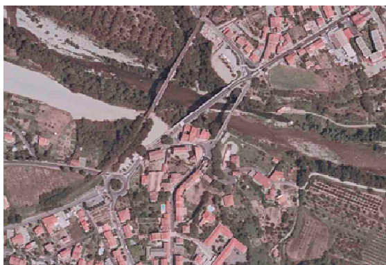
Vue aérienne des Ponts de Céret
