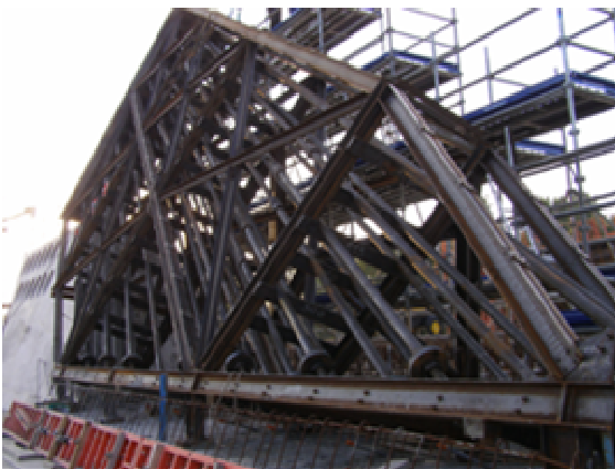
Connexion entre la pile de pont sur rive et les deux structures métalliques treillis supportant les tirants d'ancrage des câbles porteurs
