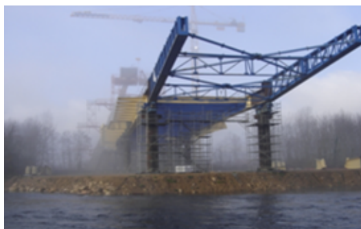
Photo après le premier lancement
