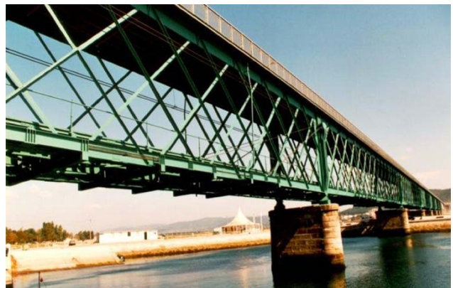
Pont mixte sur le fleuve Lima à Viana do Castelo
