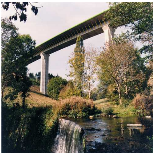
Le viaduc du Piou
