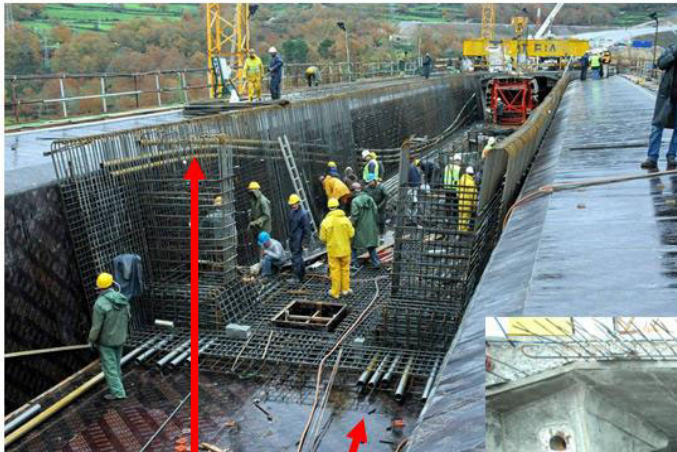
Mise en place du ferrailage
