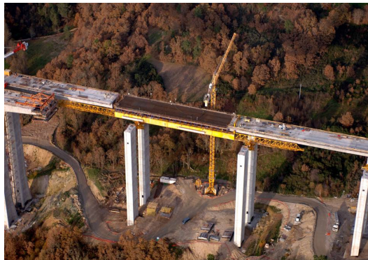
Position de bétonnage avec report arrière des charges sur béton
