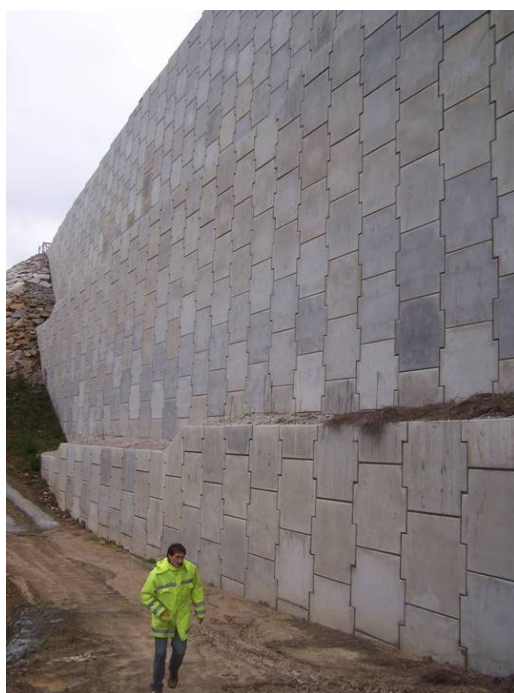
Soutènement Terre Armée® h = 30m
