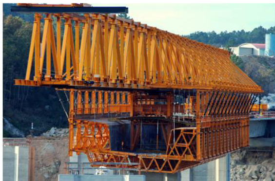
Coffrages en position fermée
