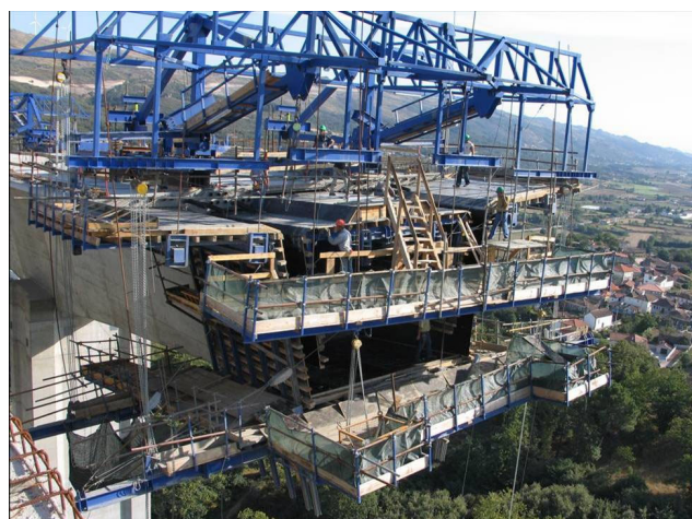
Dispositif avant de reprise des charges
