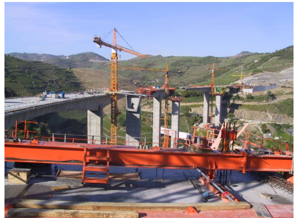
Report des charges de l'équipage sur le tablier
