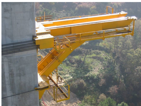
Consoles provisoires de translation serrées sur les piles
