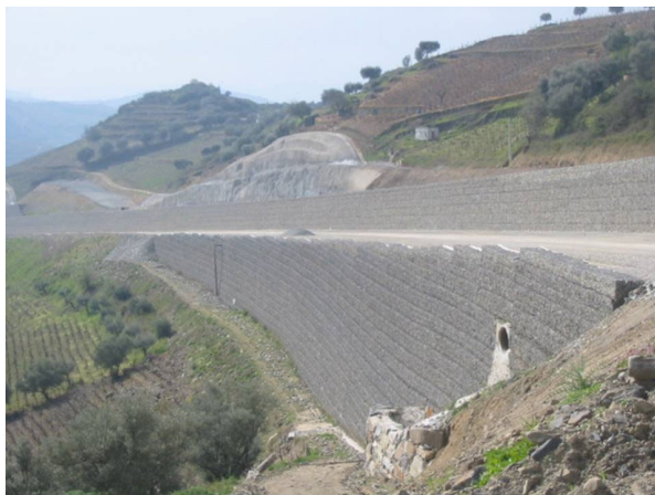
Chaussées dénivelées en amont d'un soutènement remblai renforcé
