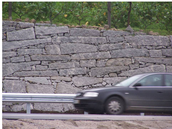
Pratique locale des murs de soutènement en « pierres sèches »
