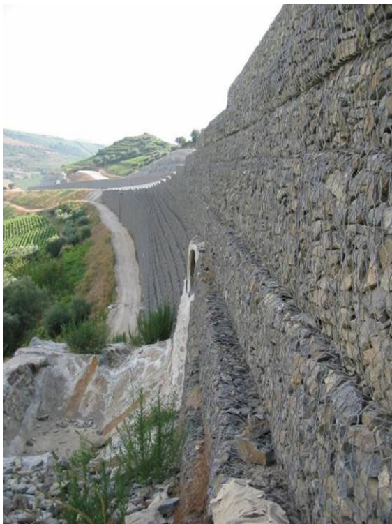
Soutènement à parement gabions
