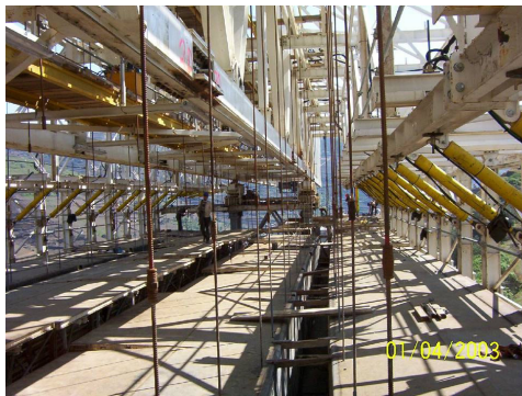
Préparation d'un bétonnage
