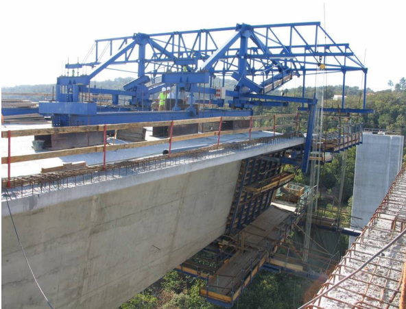
Dispositif arrière de reprise des charges
