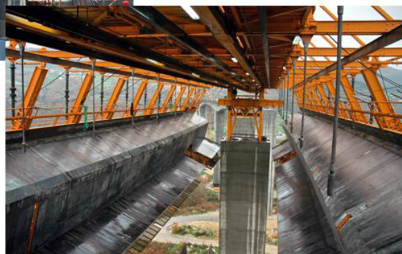
Détail de l'intérieur du coffrage
