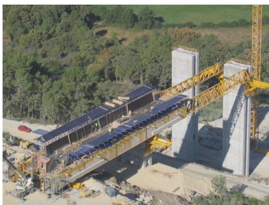
Position de bétonnage avec report arrière des charges sur béton
