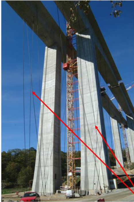
Haubanage de stabilisation
