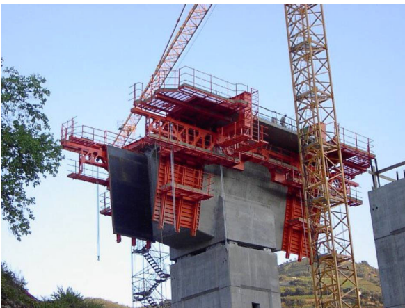
Des équipages fixés sur poutres latérales rigides
