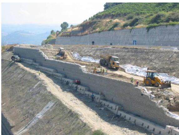
Cascade de soutènements
