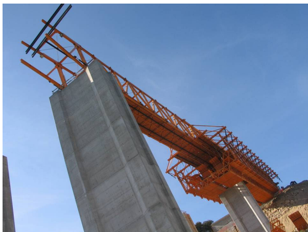
Un important avant-bec pour les phases de translation
