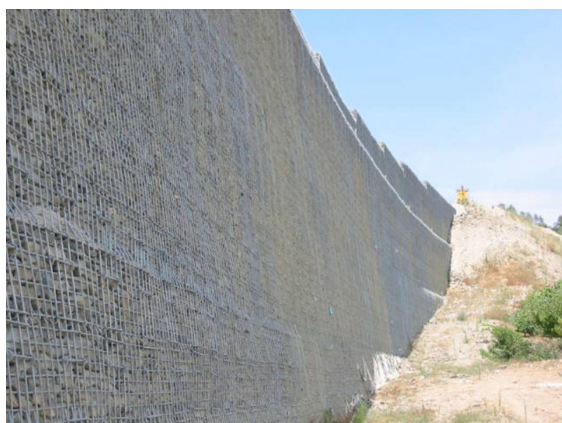
Soutènement à parement treillis soudé
