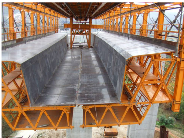
Préparation de l'outil pour bétonnage d'une travée
