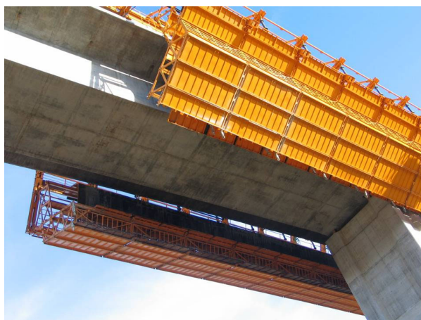
Outil ouvert pour translation après coulage : face inférieure
