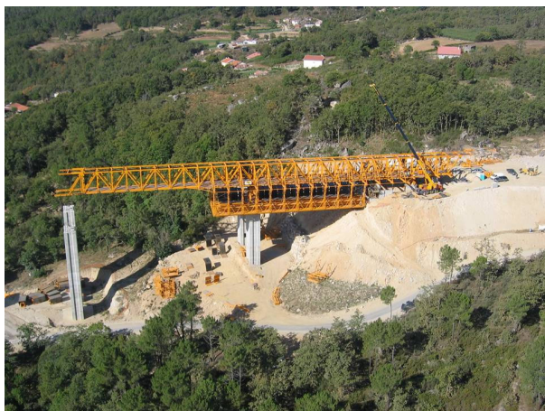
Une poutre importante et monolithique
