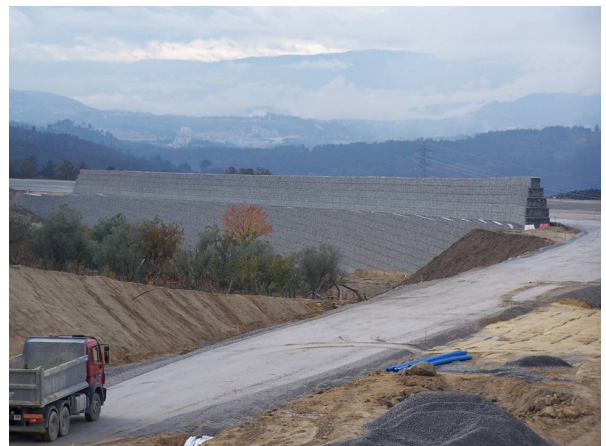
Soutènement en remblai renforcé avec parement gabions, surélevé gabions constituant écran acoustique
