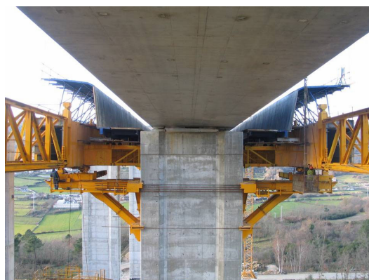
Poutres libérées pendant le transfert longitudinal
