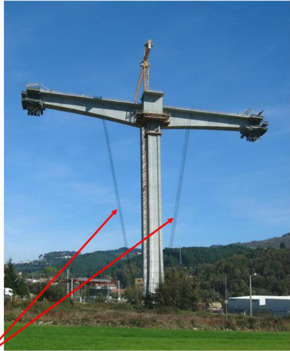
Haubanage de stabilisation
