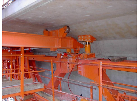
Dispositif d'appui à l'arrière des poutres latérales
