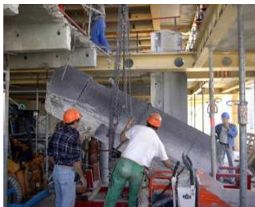
Détail de découpe d'une ancienne façade
