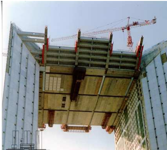
Vue de la construction du toit de l'Arche
