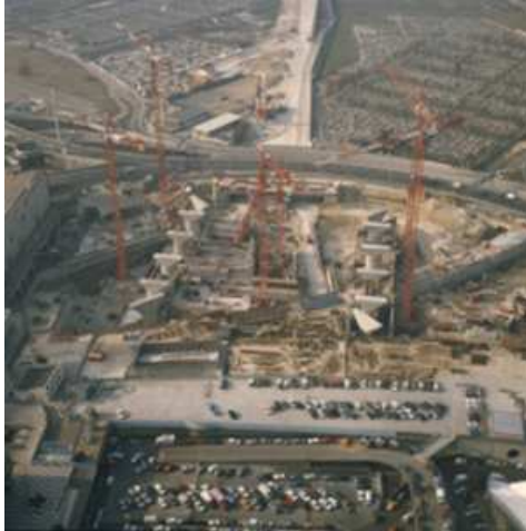
Piles de fondation de l'Arche
