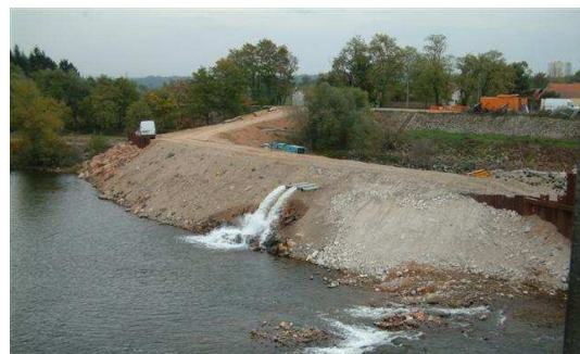
Le batardeau en aval
