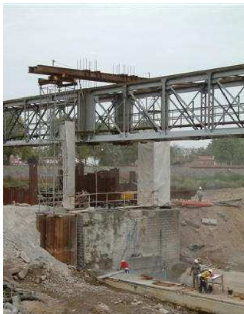
La base de la pile P3 et la poutre treillis étayée
