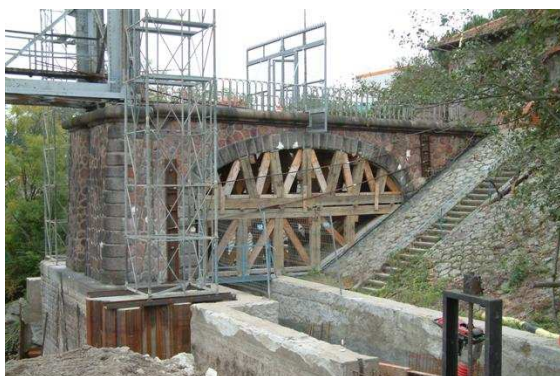
La voûte, rive droite, étayée et munie de tirants métalliques
