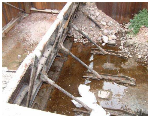
Hausses Aubert avec le système béquille-crémaillère
