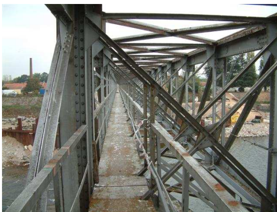
La passerelle de la poutre treillis
