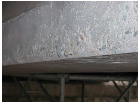
Préparation (reprofilage + meulage) Freyssinet
