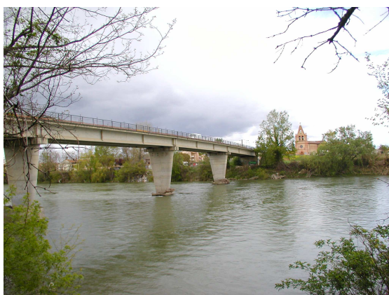
Vue d'ensemble (photo CDOA)
