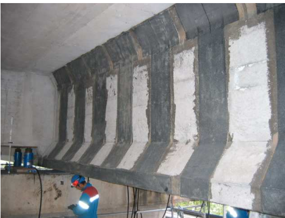
Pose du TFC en cours + poutre terminée Freyssinet
