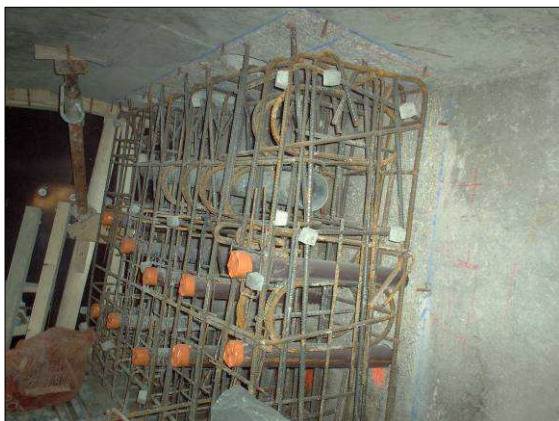
Figure 10 - Ferrailage d'un massif d'ancrage
