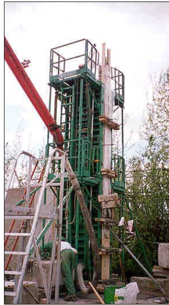
Photo 3 : Injection de BAP par le bas
