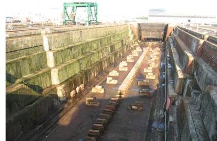
Forme de radoub (Ouvrages de construction et de réparation navale)
