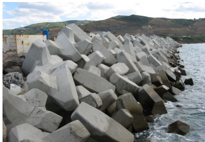
Digue en enrochements artificiels (Ouvrages de protection contre la houle)
