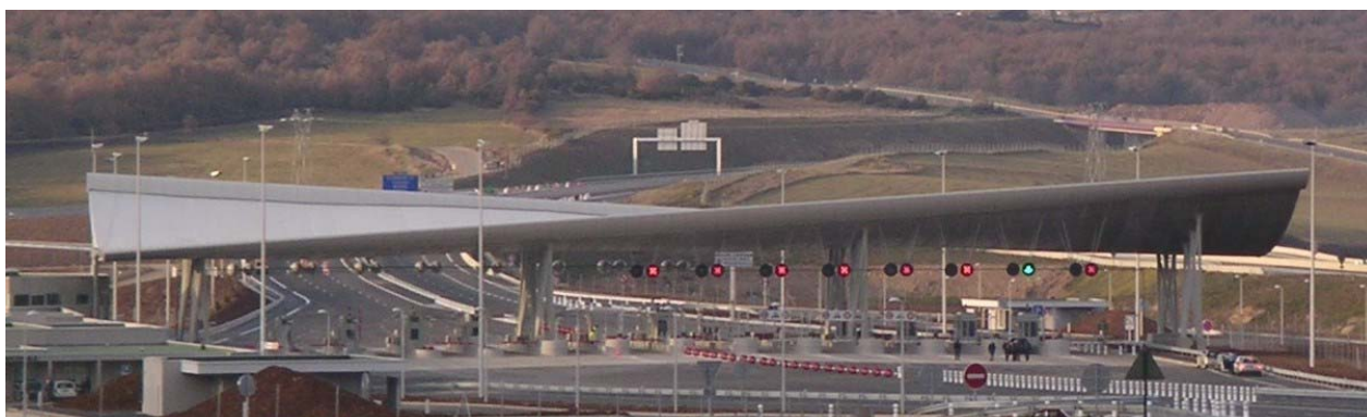
Photo 13 : Vue d'ensemble de l'ouvrage
