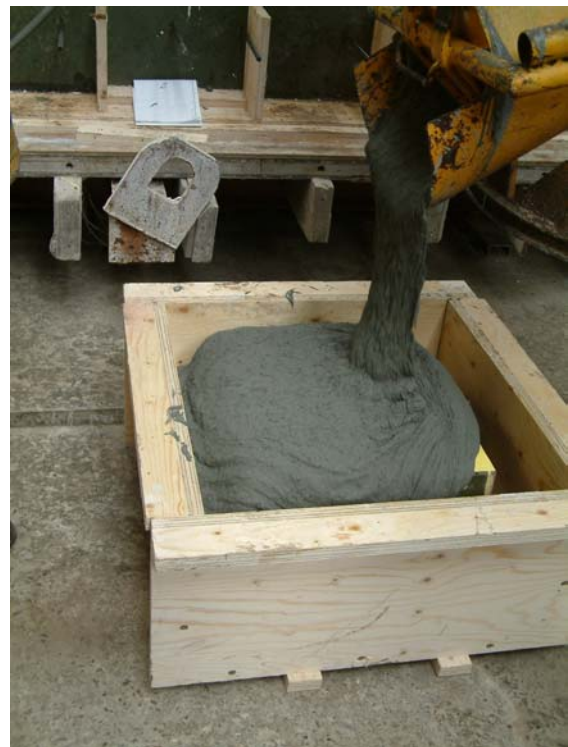
Photo 2 - Coulage d'une alvéole
