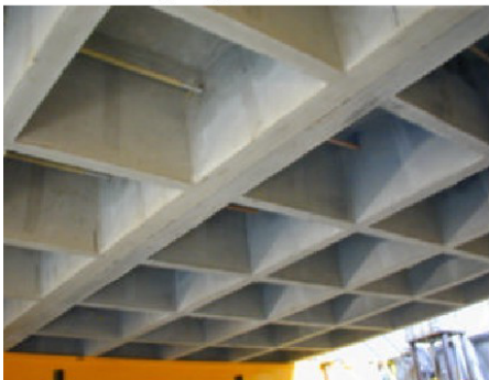
Photo n°3 - Corps d'épreuve vu de dessous
