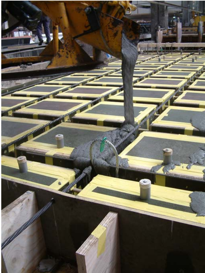
Photo 1 – Dalle d'essai Ductal® en cours de bétonnage.
