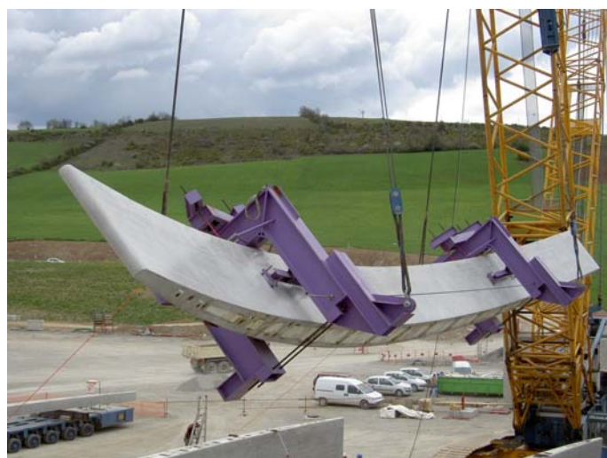
Photo 14 : Levage et retournement d'un voussoir
