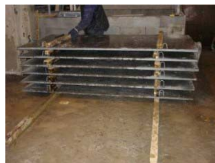
Photos 10 – Manutention des prédalles
