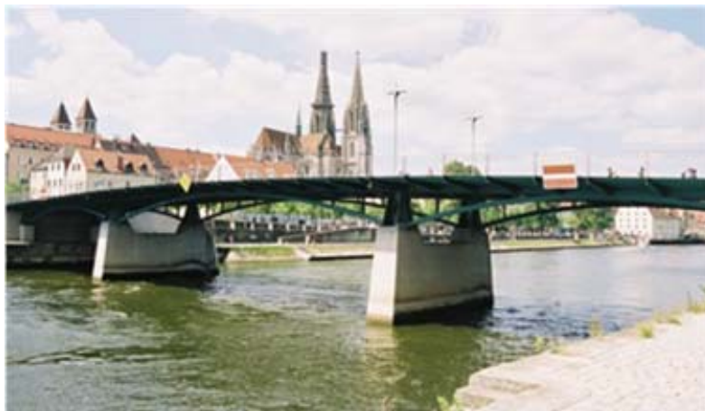
Figure 6 : Pile et connexion pile-poutre pour le pont d'Ingolstadt
