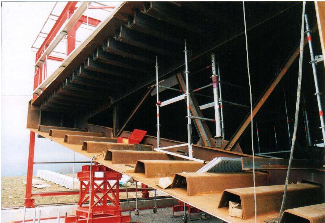
Figure 10 : Vue du caisson du viaduc de Millau
