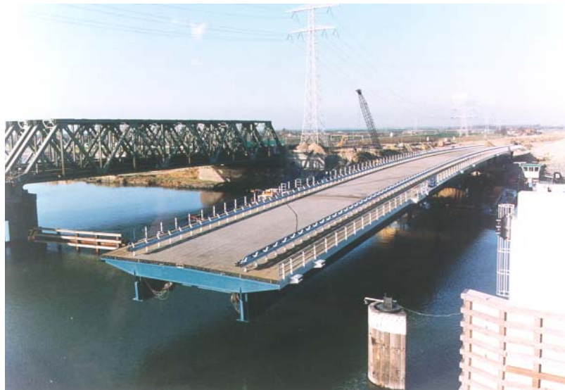
Figure 5 : Pont à Zuid-Beveland (Pays-Bas)
