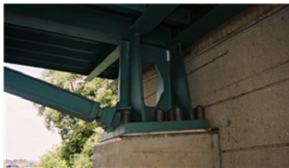
Figure 7 : Autre exemple de pont utilisant un acier S690 : Eiserne Brücke à Regensburg
