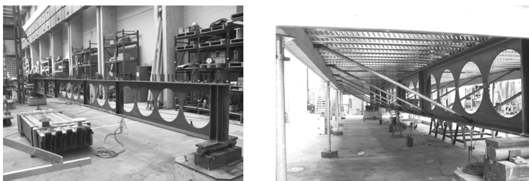
Figure 13 - Dispositif pour le coulage de la dalle de la poutre 4m
