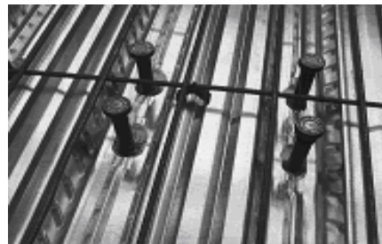
Figure 12 : Goujons soudés et bac prépercé
