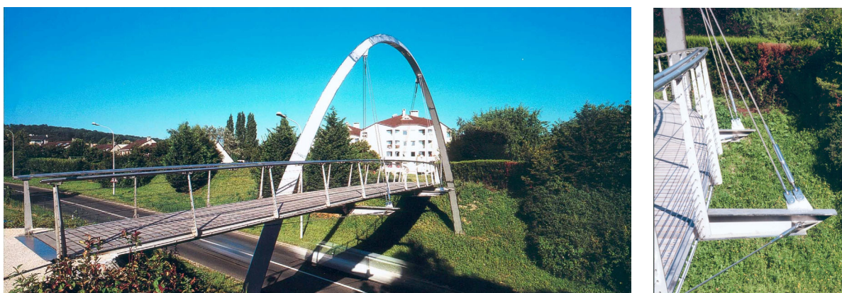
Figure 5 : Passerelle des Charveaux à Andrésy (Yvelines)
