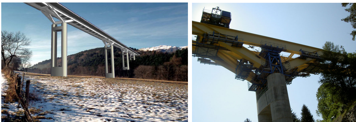
Figure 3 : Viaduc de Monestier de Clermont Un tablier mince et aérien (structure bipoutre en acier) grâce à la mise en place de bracons
