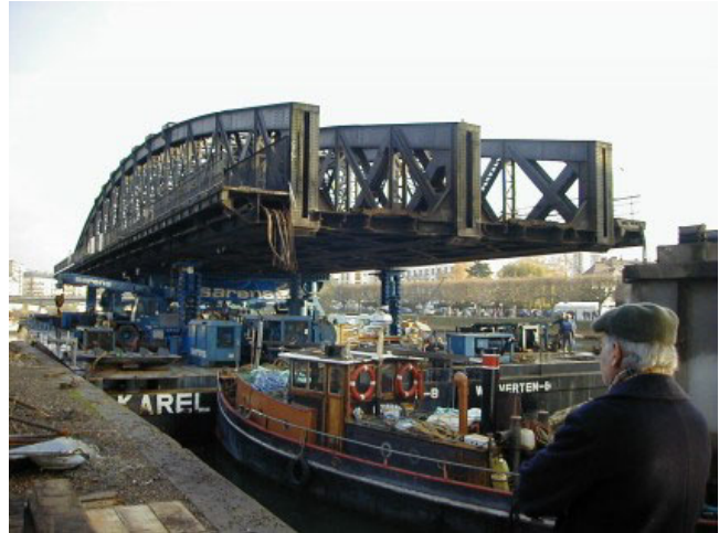
Figure 15 : Démontage du pont ferroviaire de Pontoise (1861 – 1999)
