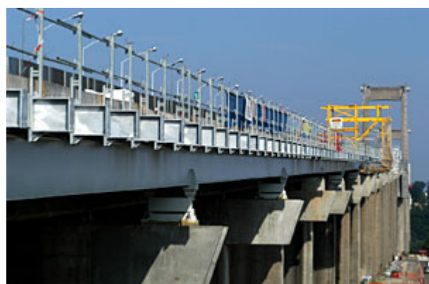
Figure 14 : Elargissement du viaduc d'accès au pont d'Aquitaine à Bordeaux
