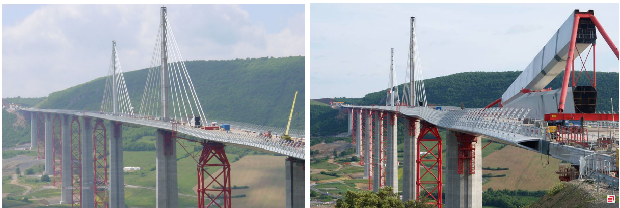
Figure 8 : Viaduc de Millau Heures de travail au sol (atelier et chantier) : 96% Heures de travail en hauteur (sur le tablier) : 4% Aucun accident de chantier à déplorer
