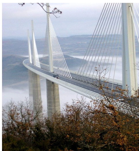
Figure 13 : Viaduc de Millau - Durée de vie initiale prévue à la conception : 120 ans (compte non tenu d'un allongement possible grâce à l'entretien, la maintenance et d'éventuelles réhabilitations)
