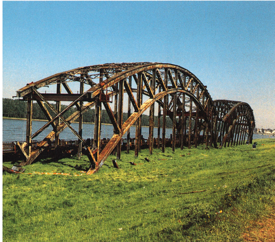
Figure 14 : Démontage du pont de Hammer à Düsseldorf
