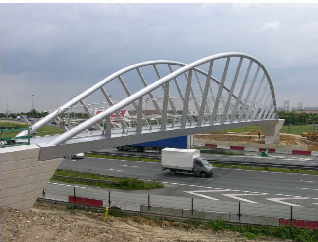
ill. 21 – Projet de passerelle à Villepinbte / Photo de chantier
