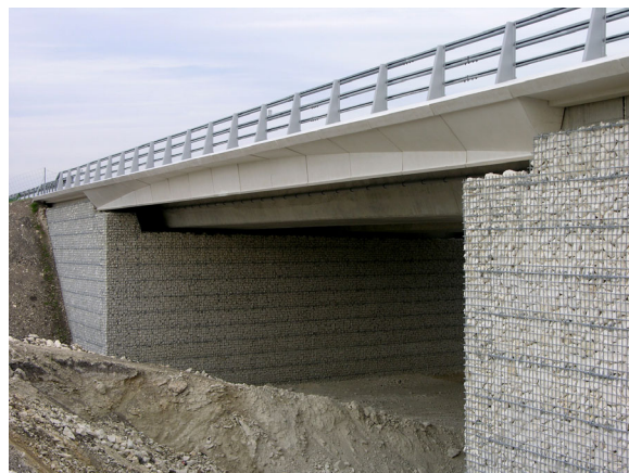
ill.11 – Projet d'ouvrage pour la RCEA à Saintes / Photo de chantier
