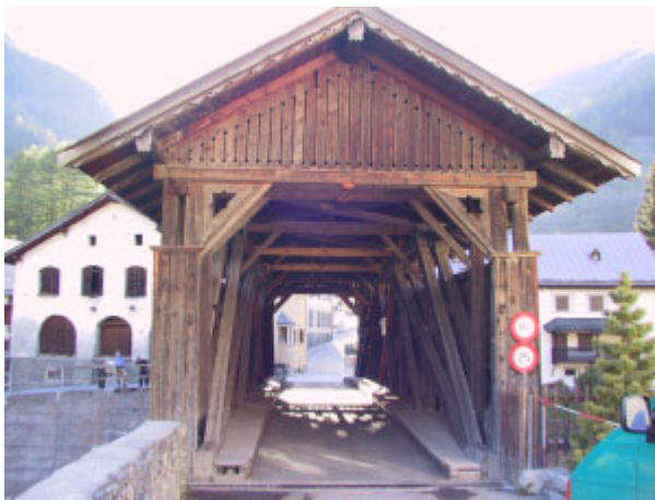
Photo 3 : Pont de Susch en Suisse
