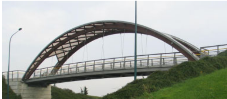
Photo 7 : Passerelle Pinot : les arcs sont en bois, les tirants et les suspentes en acier et la dalle en béton
