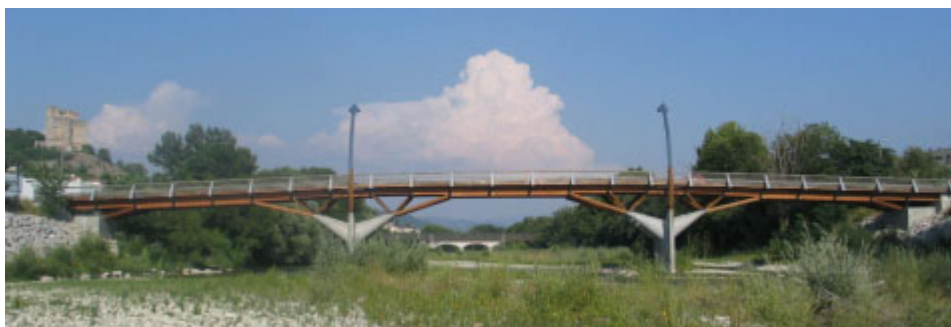
Photo 5 : Pont de Crest : structure protégée par une dalle béton
