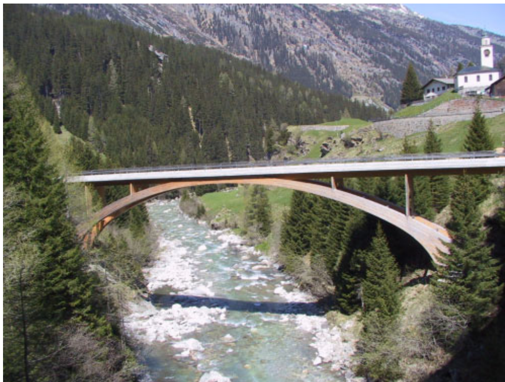
Photo 8 : Pont d'Innenferrera en Suisse : la dalle en béton protège la structure en bois
