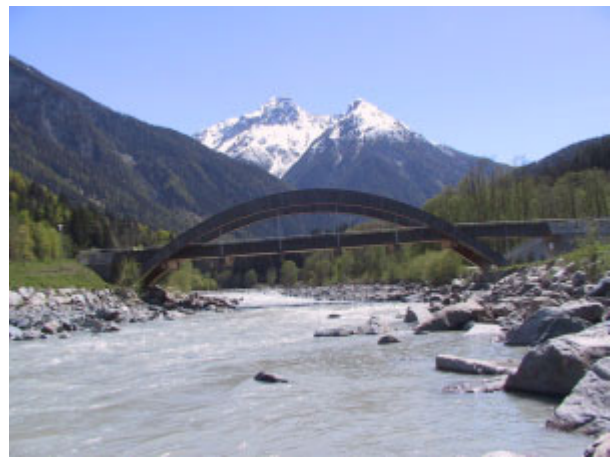
Photo 4 : Pont à Strada en Suisse en arc bardé avec du mélèze, de 39 m de portée et 48 m de longueur
