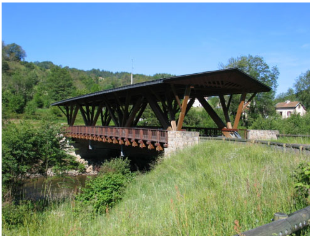
Photo 6 : Pont sur la Dore : la structure est entièrement protégée par la toiture
