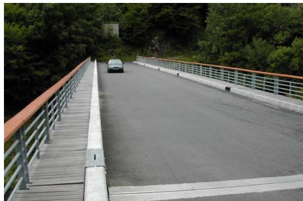
Dalle de couverture en béton
