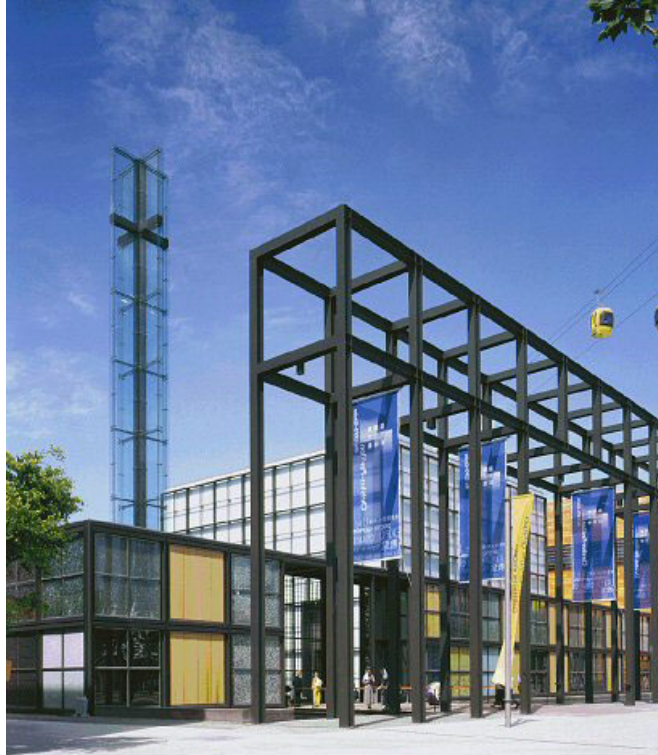
Figure 9: Pavillon du Christ à l'Exposition Mondiale à Hanovre - structure à base de poutrelles utilisées pour la construction d'une église et d'un laboratoire après démontage du bâtiment d'origine.
