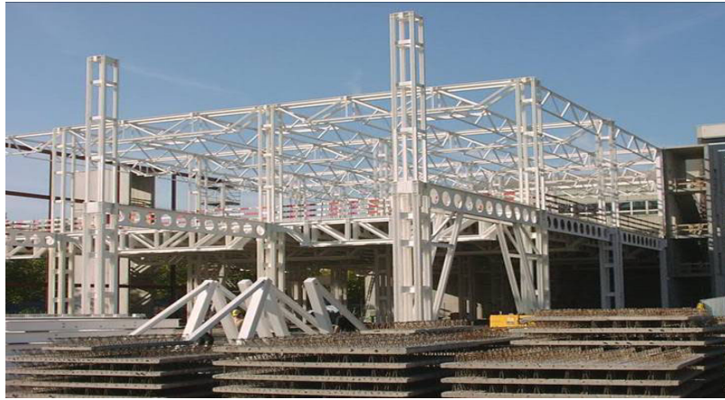
Figure 7: Chantier de construction type d'une structure en acier avec éléments préfabriqués
