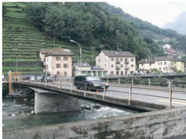
Figure 1 - Vue du pont
