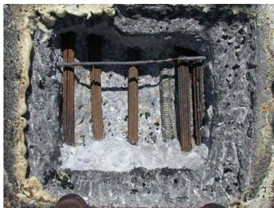
Figure 2 - Etat de la précontrainte avant installation de la surveillance acoustique
