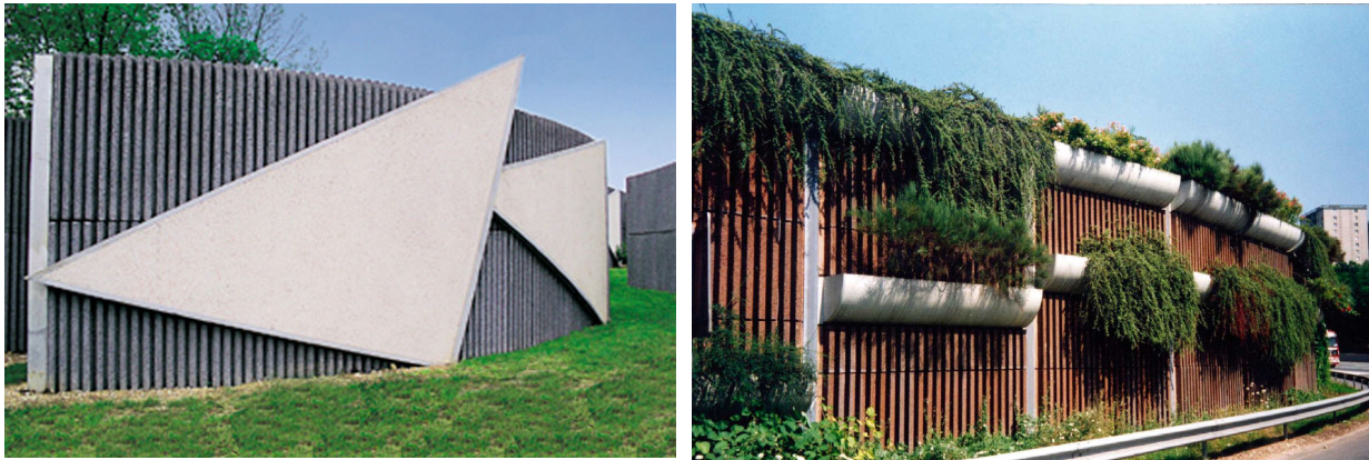
Figure 10 : Ecrans acoustiques en béton de bois et végétalisable
