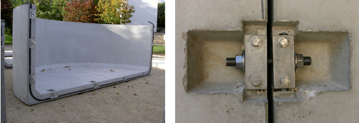
Figure 6 : Exemples d'assemblage d'éléments de bassins
