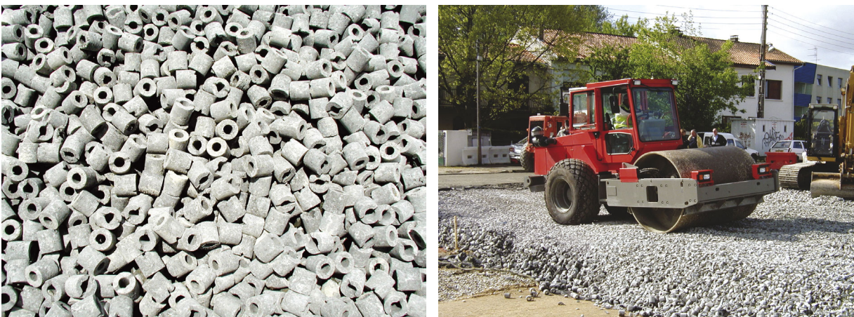
Figure 7 : Produits creux en béton pour chaussée réservoir
