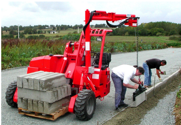
Figure 14 : Pose mécanisée de produits de voirie
