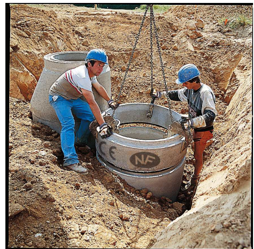
Figure 13 : Maintenance au moyen d'équipement de préhension spécifique
