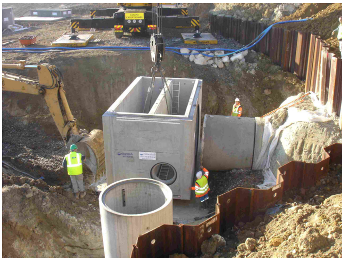
Figure 12 : Maintenance au moyen d'inserts positionnés dans le radier du produit
