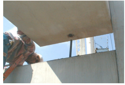
Pose des dalles
