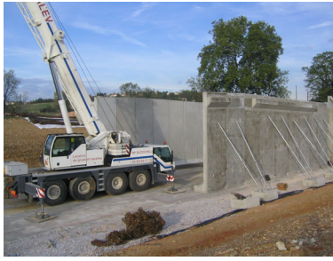
Pose des pénétrations
