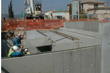
Régulation des dalles
